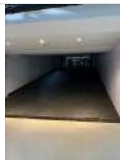
Rampa de Acesso Garagem
