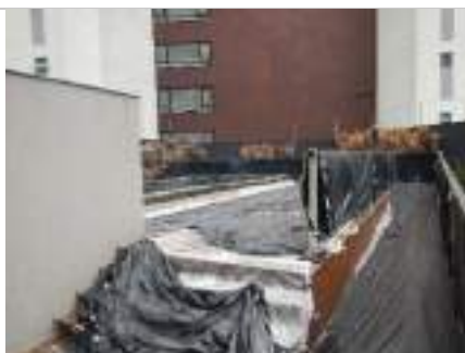
Piscina (em construção)
