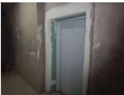
Hall e elevador de serviço
