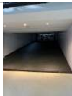
Rampa de Acesso Garagem
