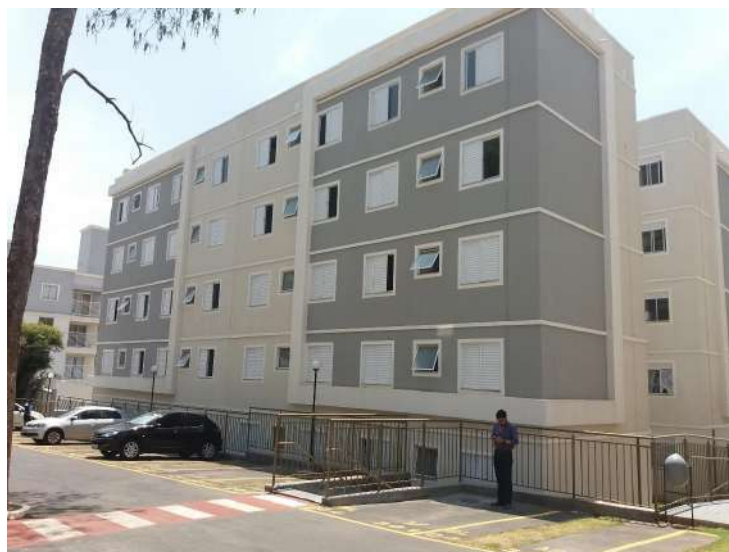
geral do imóvel
