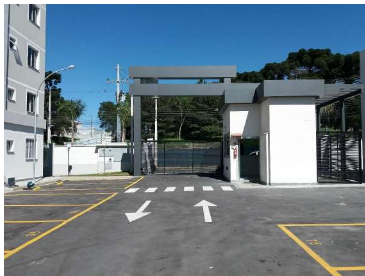
Vista do acesso externo do imóvel
