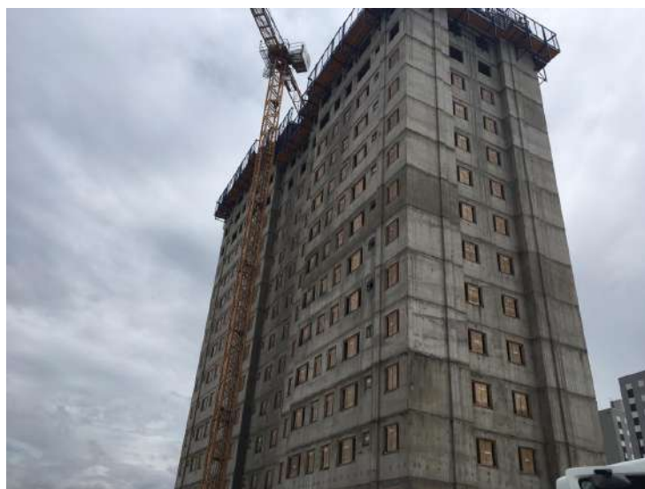
Visão geral do imóvel
