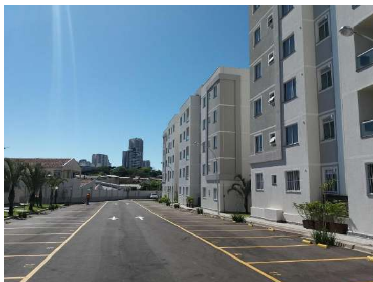
Pátio do estacionamento e vista geral do imóvel
