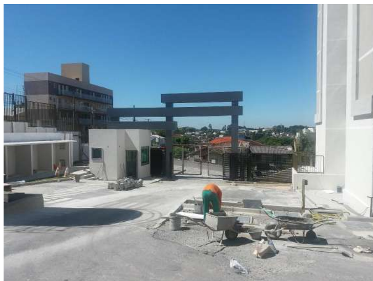
Vista do acesso externo do imóvel
