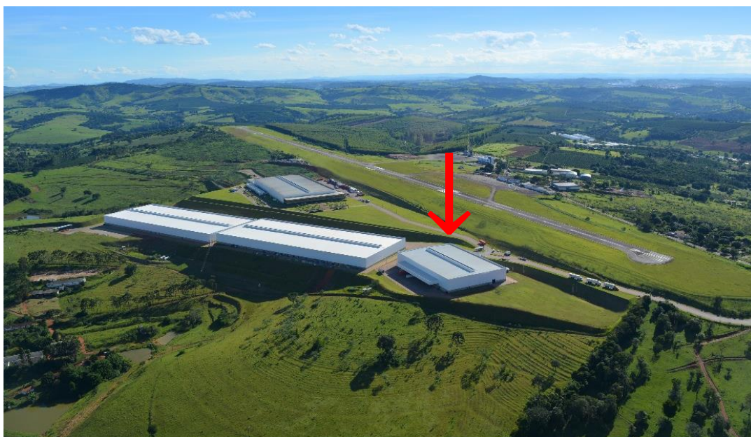
VISTA GERAL DO EMPREENDIMENTO (GALPÃO INDICADO)
