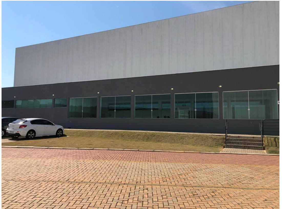
VISTA EXTERNA DO GALPÃO E ADMINISTRATIVO
