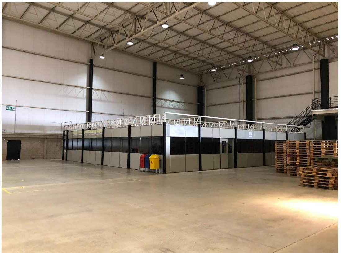
VISTA INTERNA DO GALPÃO
