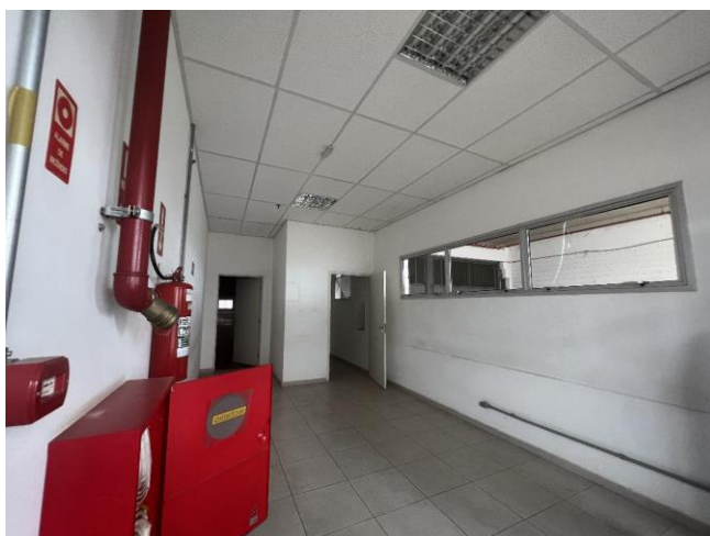
VISTA INTERNA – RECEPÇÃO GALPÃO
