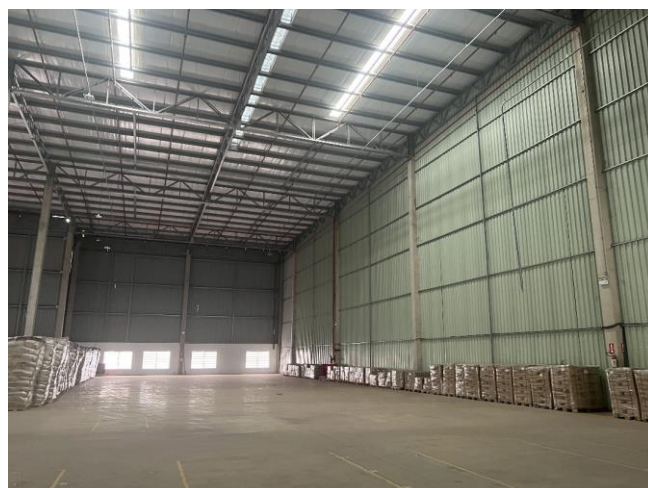
VISTA INTERNA - GALPÃO
