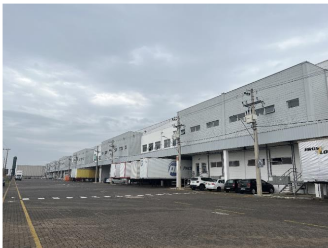
VISTA EXTERNA - GALPÃO
