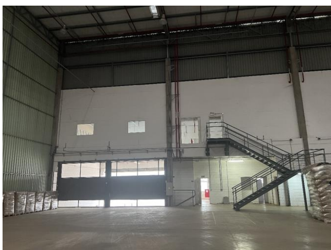
VISTA INTERNA - GALPÃO
