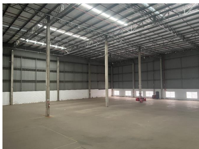
VISTA INTERNA - GALPÃO
