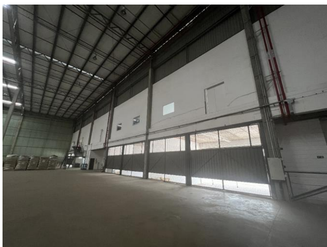
VISTA INTERNA - GALPÃO
