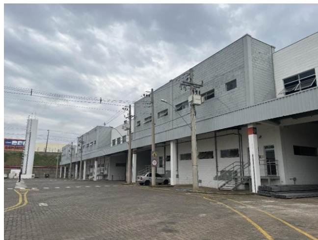
VISTA EXTERNA - GALPÃO
