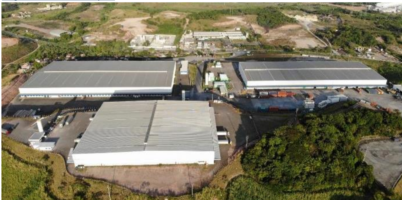
Imagem 3: Foto Aérea dos Galpões
