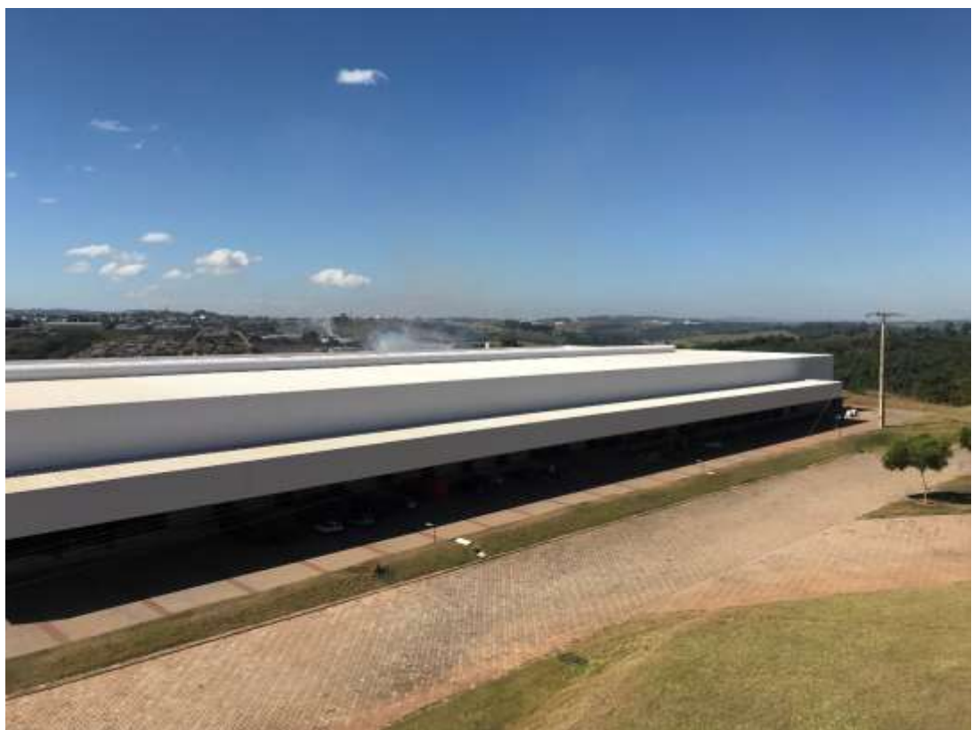
VISTA GERAL DO GALPÃO
