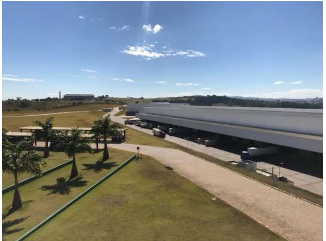
VISTA GERAL DO GALPÃO
