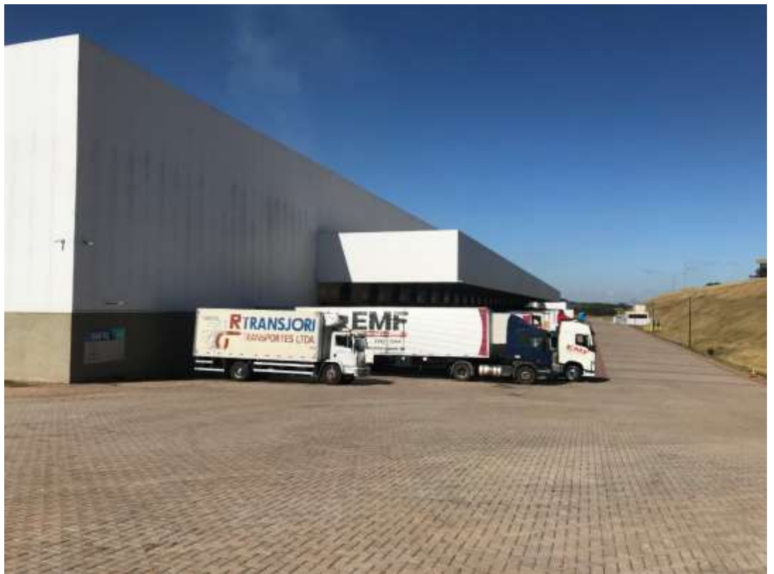
VISTA DO PÁTIO DE MANOBRAS
