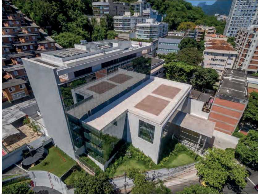
VISTA AÉREA DO EDIFÍCIO
