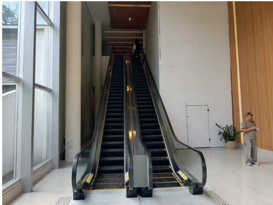
ESCADAS DE ACESSO À RECEPÇÃO
