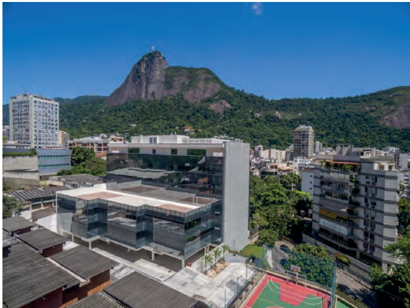
VISTA AÉREA DO EDIFÍCIO
