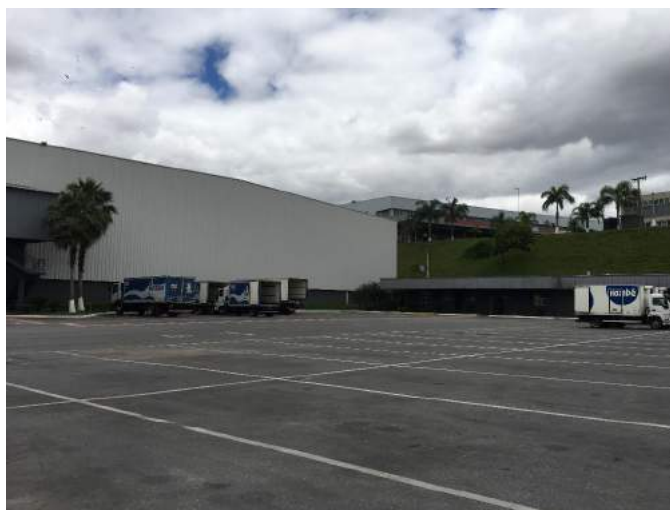
Área de estacionamento de caminhões
