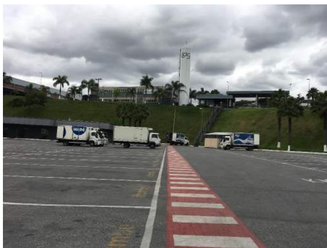
Área de estacionamento de caminhões
