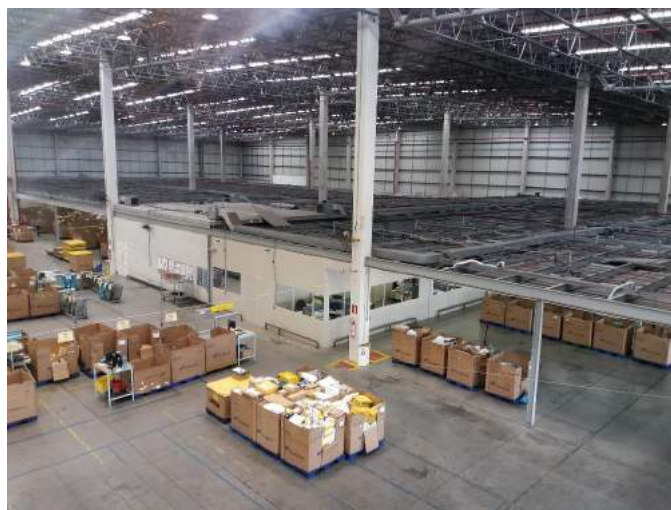
Área interna do galpão
