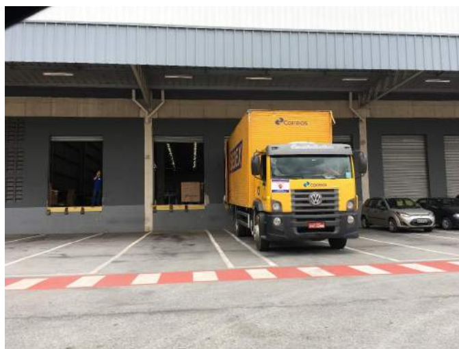
Área de galpão e marquise
