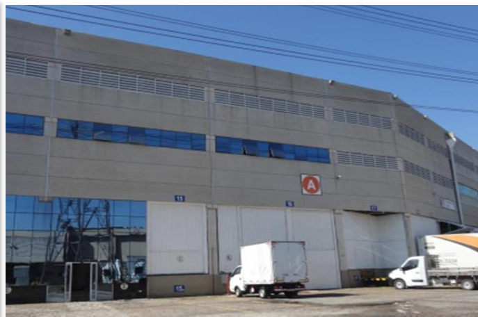
Foto do Galpão
