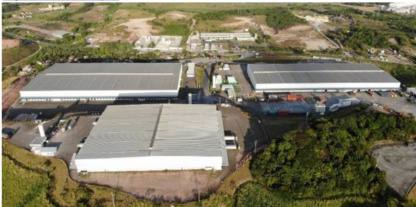
Imagem 3: Foto Aérea dos Galpões
