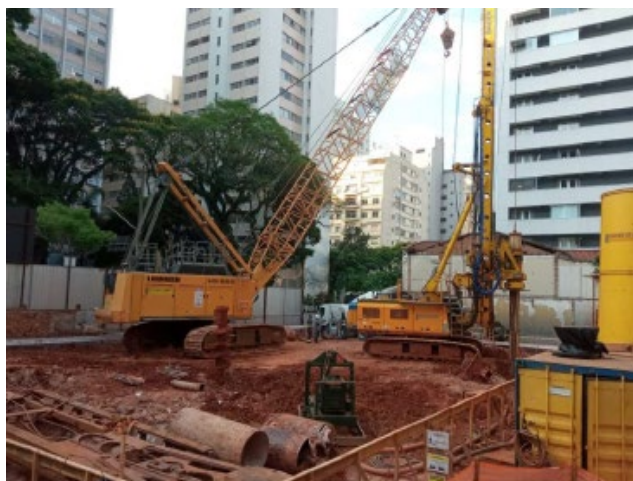
Fundações Profundas – Execução de Estações. Fonte: Planservice.
