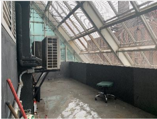
Área técnica do edifício
