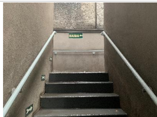
Escada de emergência – rota de fuga
