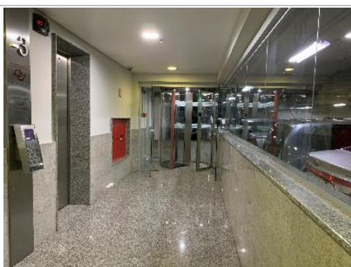
Subsolos – Hall de elevadores e torniquete
