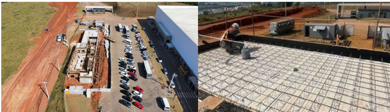
Foto obra restaurante Citlog Sul de Minas.
