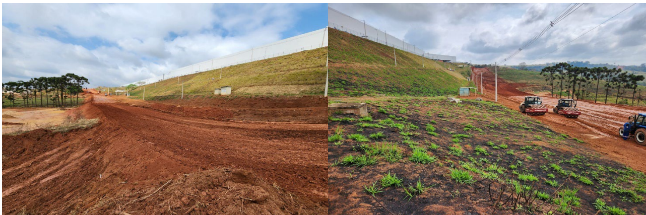
Fotos da via em obra.
