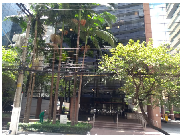
Vista Externa do Imóvel Avaliando.
