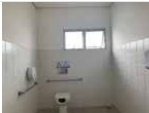
Sanitário PNE – Galpão
