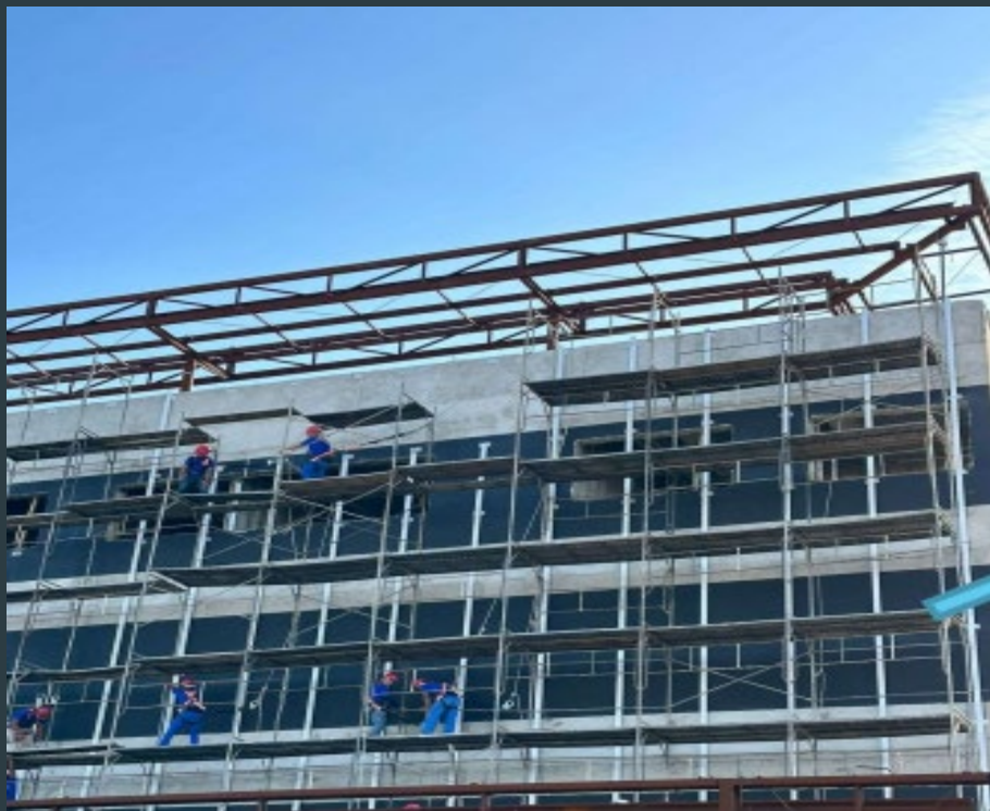
Fachada – Pele de Vidro
