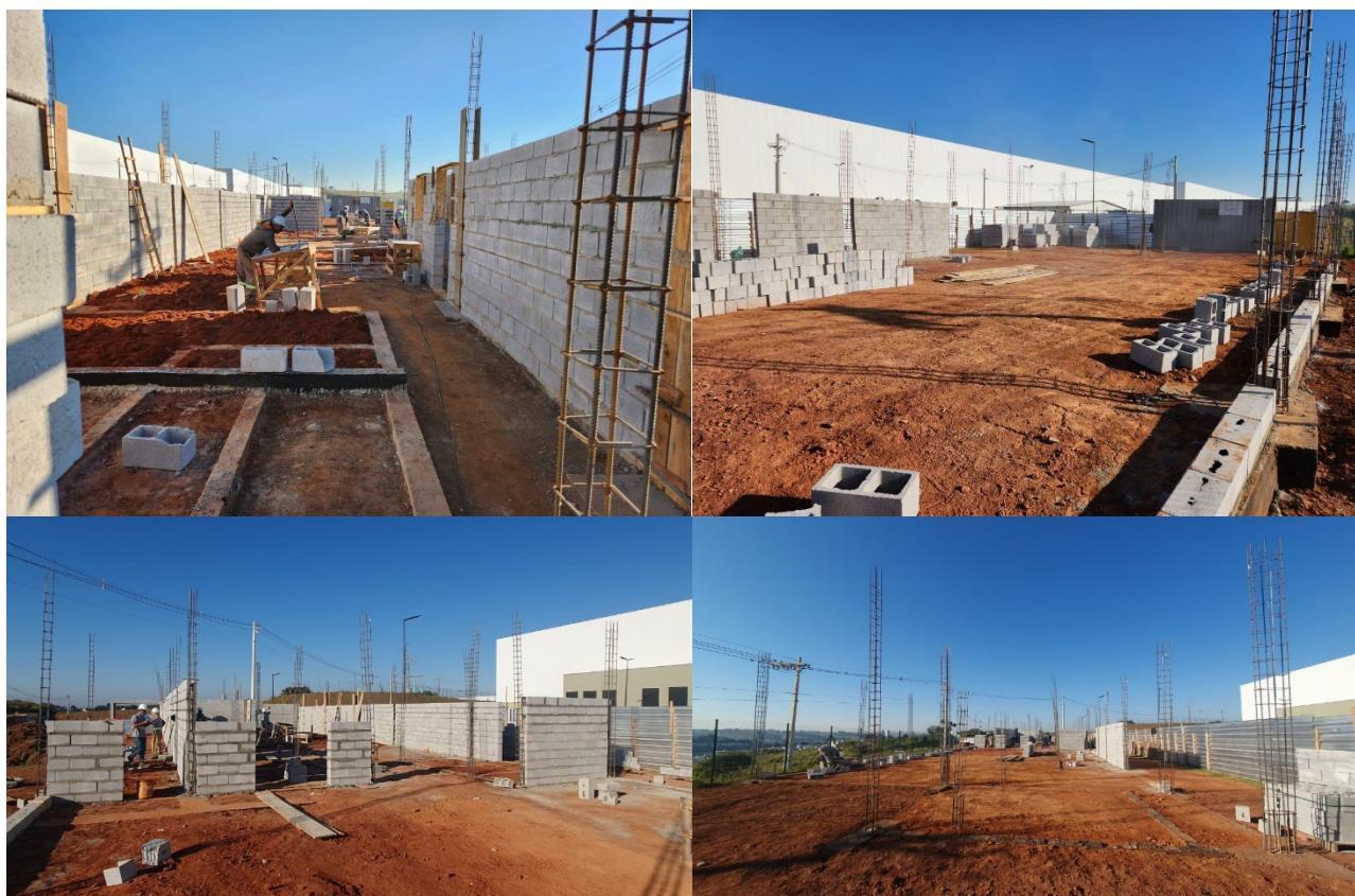
Foto obra restaurante Citlog Sul de Minas.
