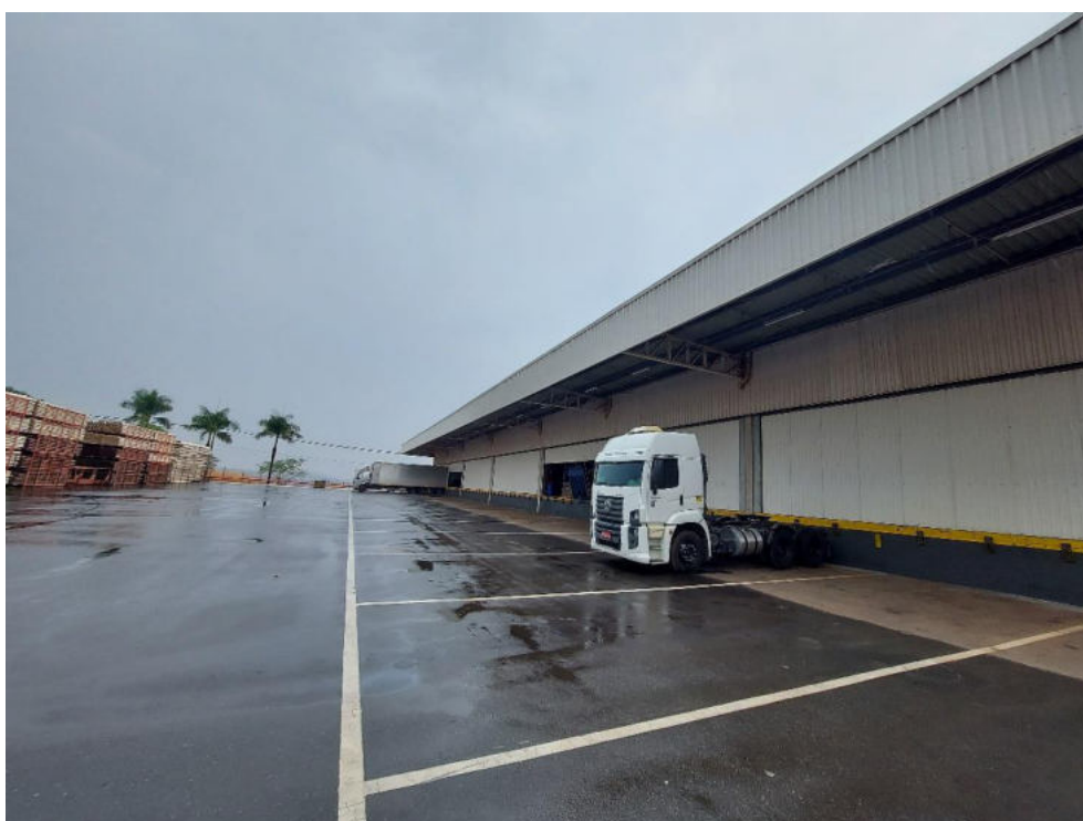
Vista geral do imóvel
