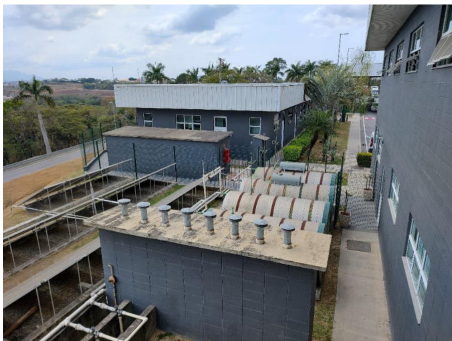
Área de comum do condomínio (Área Técnica)
