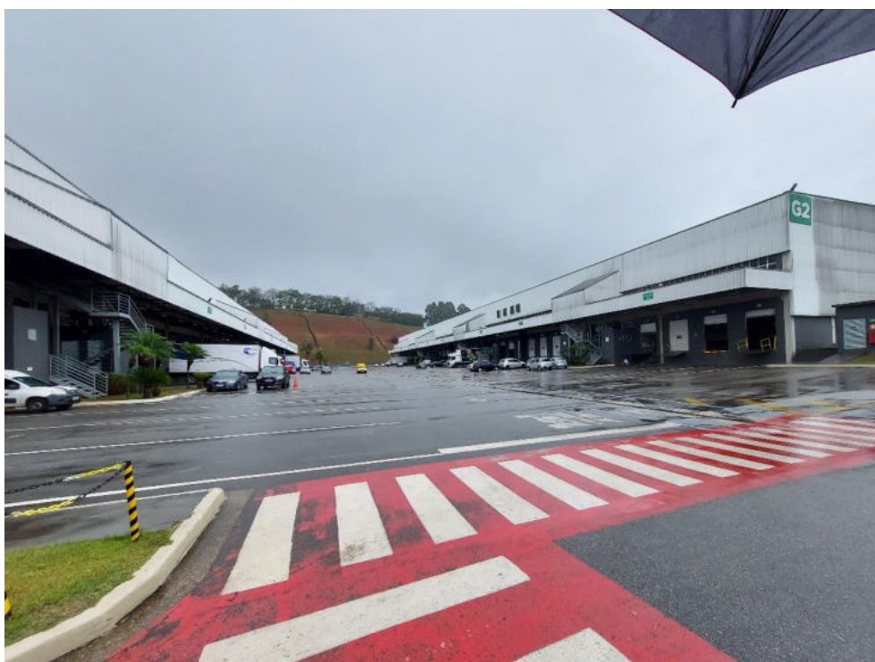
Vista geral do imóvel
