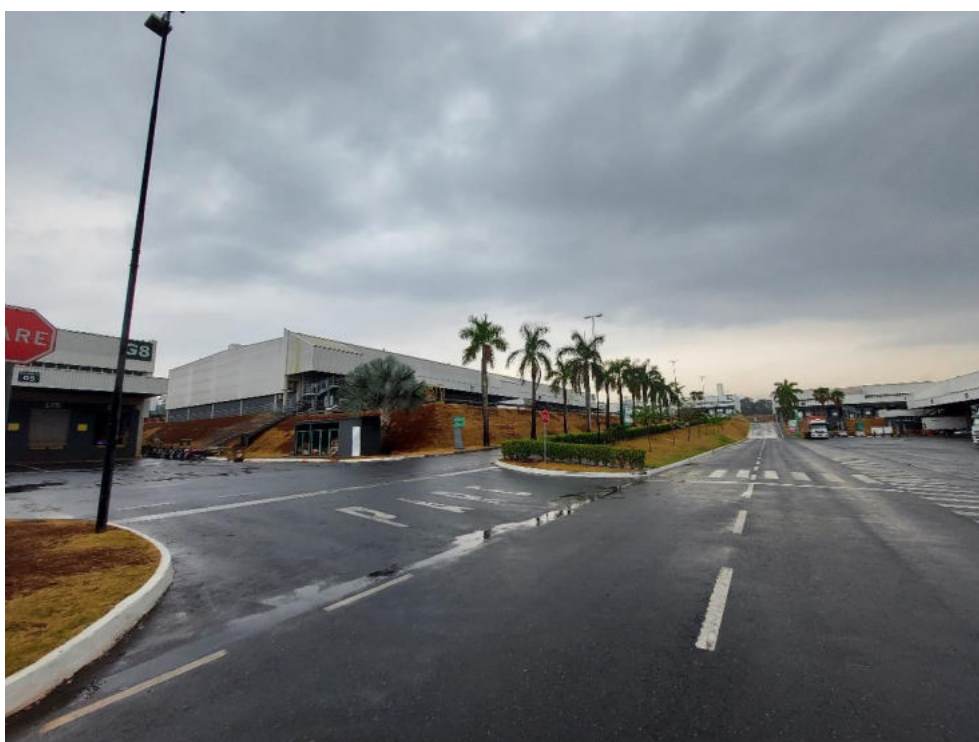
Vista geral do imóvel
