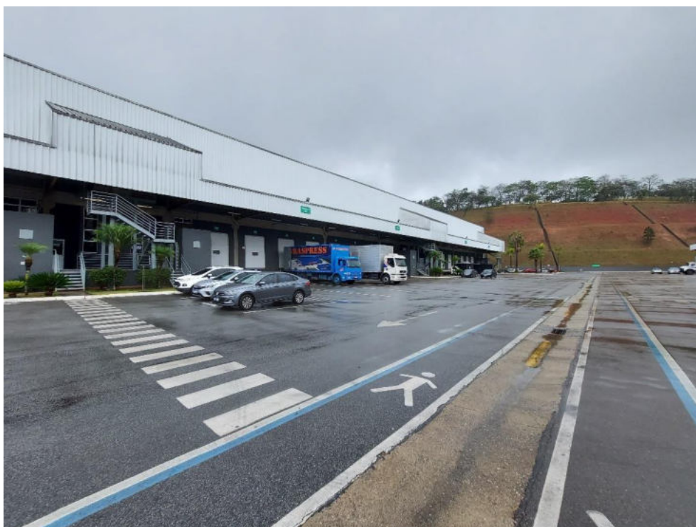
Vista geral do imóvel
