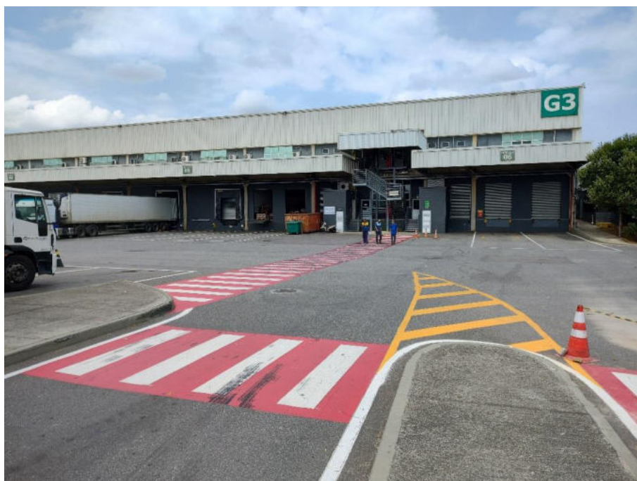
Vista externa do galpão
