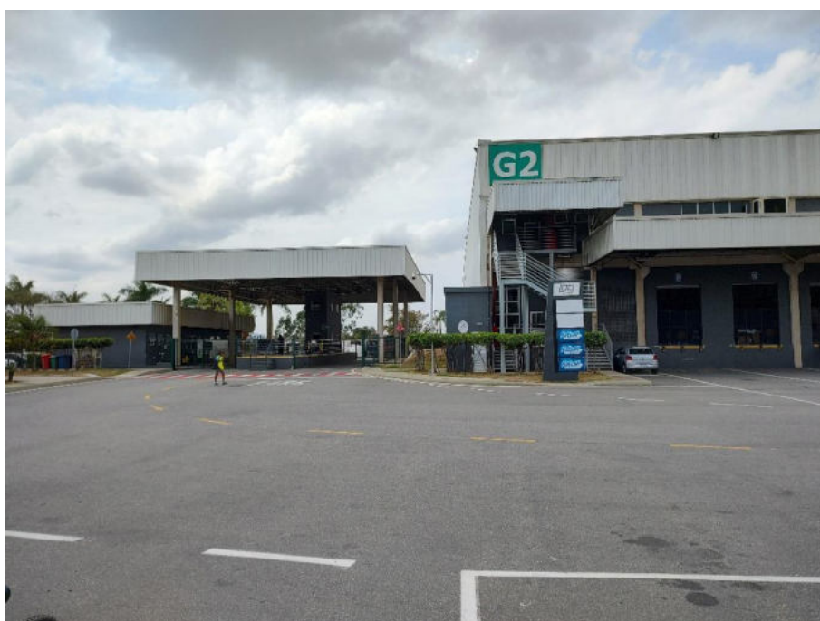
Área de comum do condomínio (Portaria)
