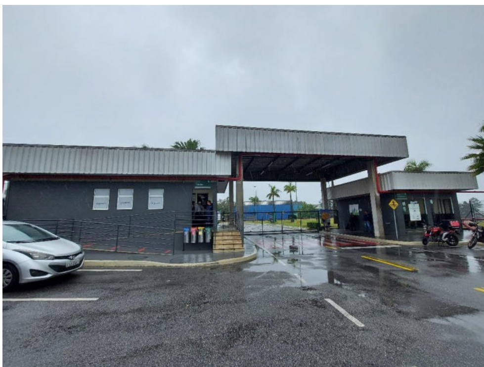
Portaria de acesso
