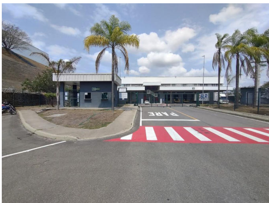
Vista externa do galpão
