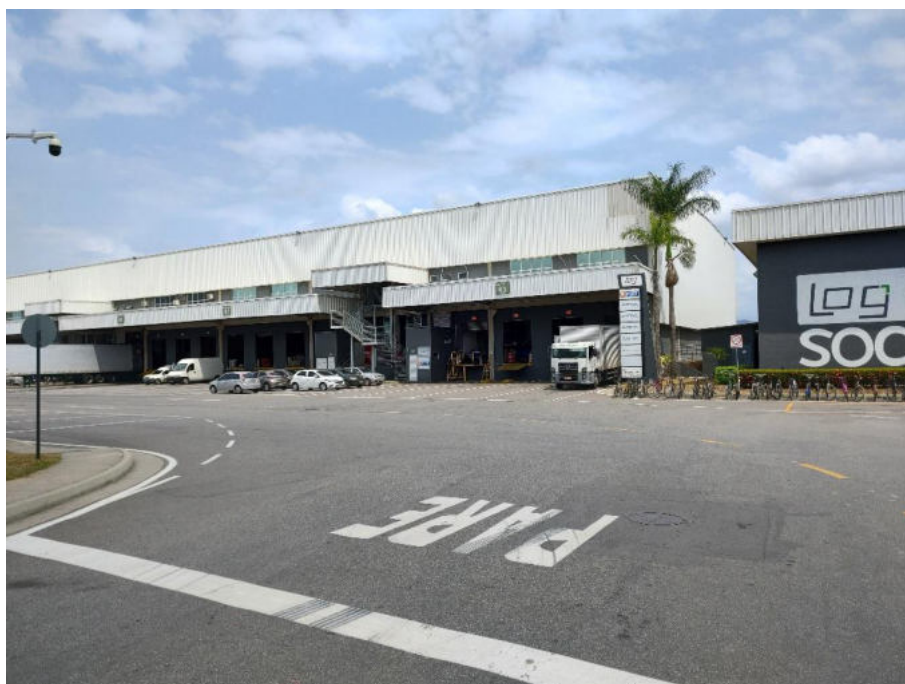
Área de manobra e docas do imóvel
