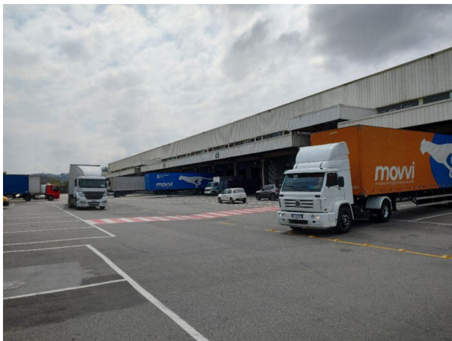
Vista externa do galpão
