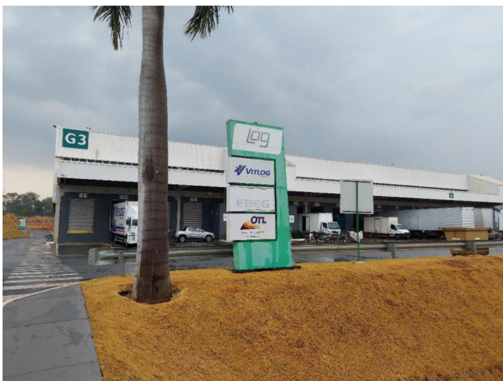
Vista geral do imóvel
