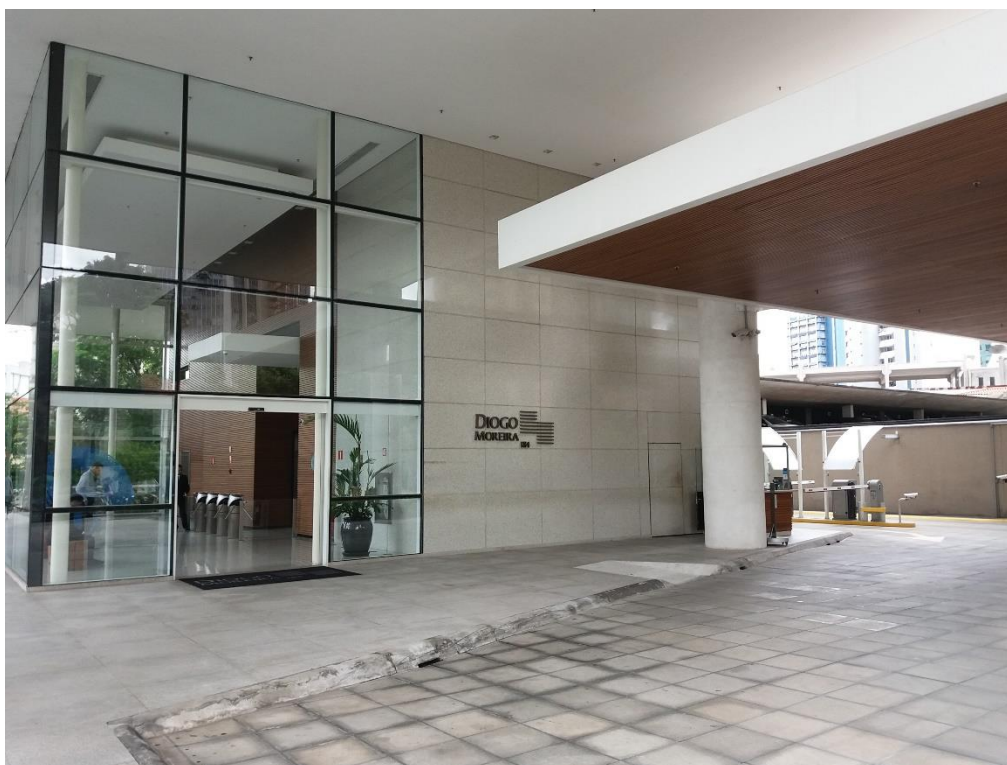
Vista do acesso principal ao imóvel
