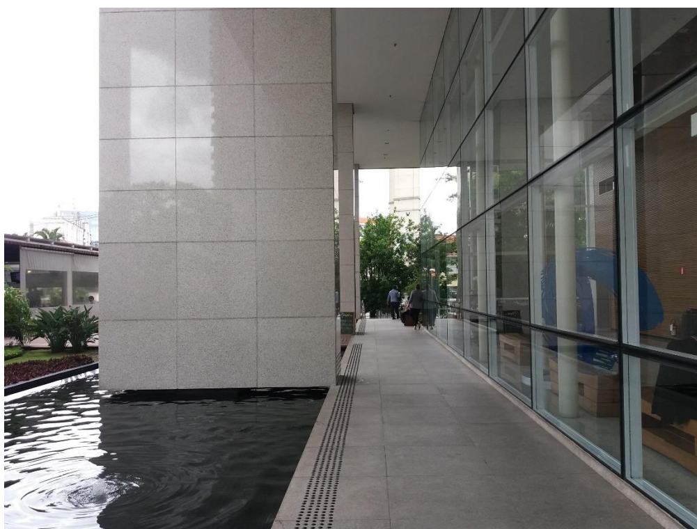
Vista da área externa
