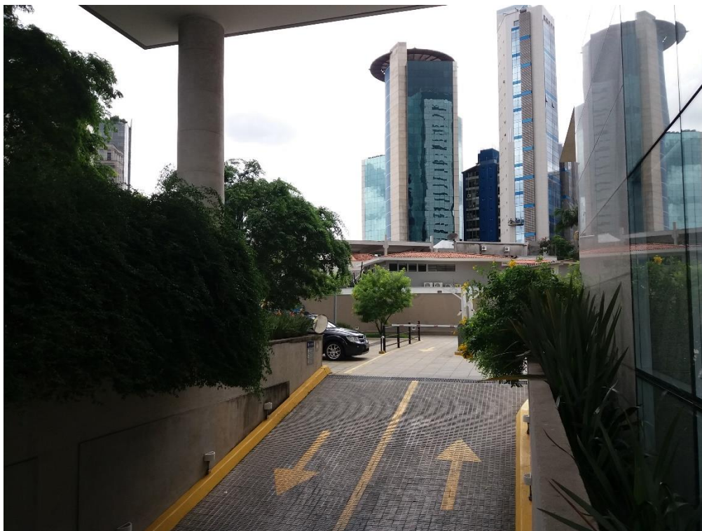
Vista da área externa do imóvel
