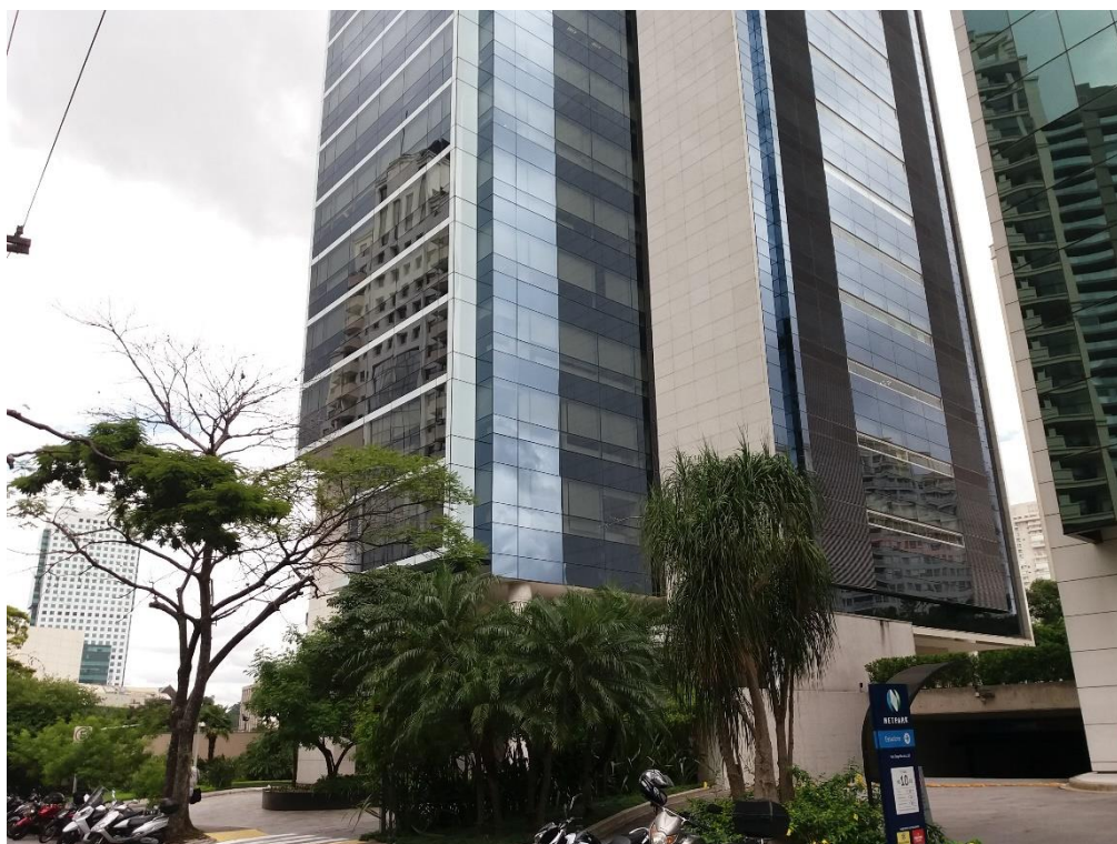
Vista da fachada do empreendimento
