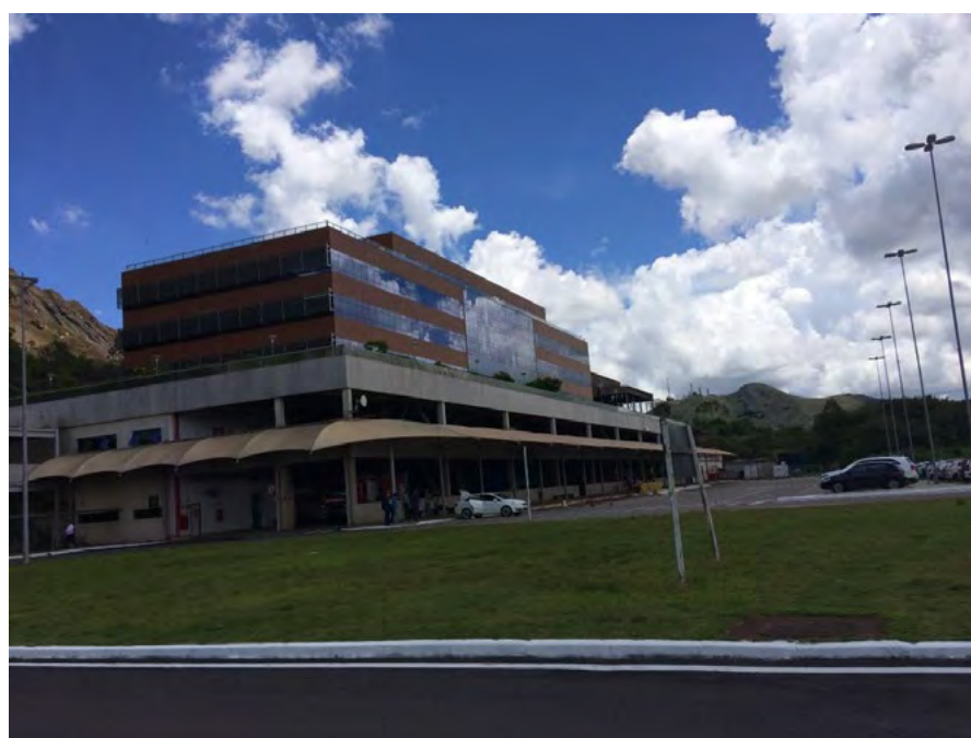
ACESSO AO EDIFÍCIO
