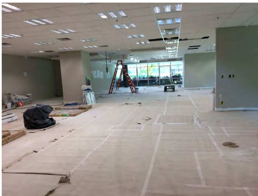
ÁREA EM REFORMA PARA OCUPAÇÃO – 1º PAVIMENTO
