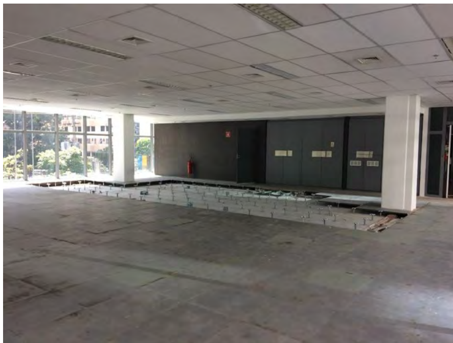
ÁREA DE ESCRITÓRIOS DO PAVIMENTO TIPO
