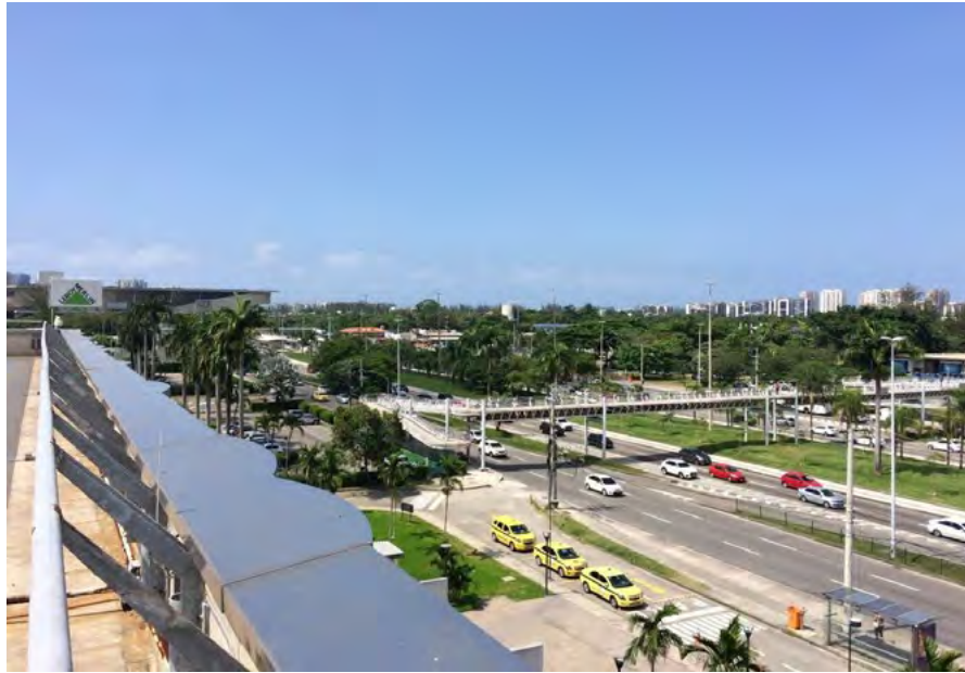
ACESSO EDIFÍCIO – AVENIDA AYRTON SENNA
