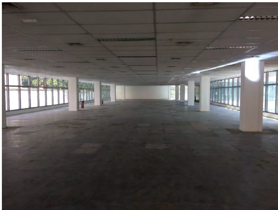
ÁREA DE ESCRITÓRIOS DO PAVIMENTO TIPO
