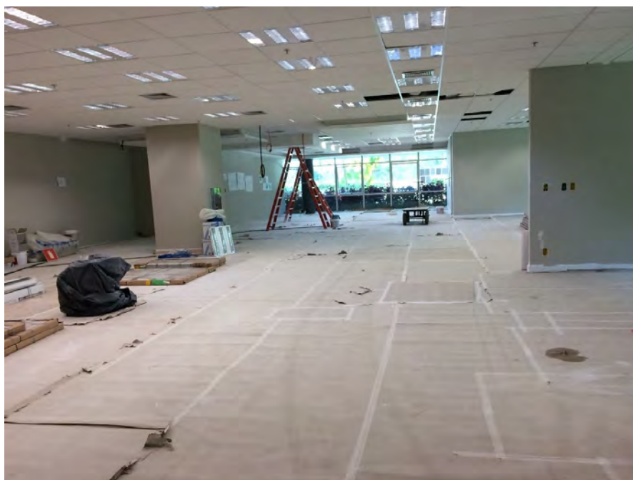
ÁREA EM REFORMA PARA OCUPAÇÃO – 1º PAVIMENTO
