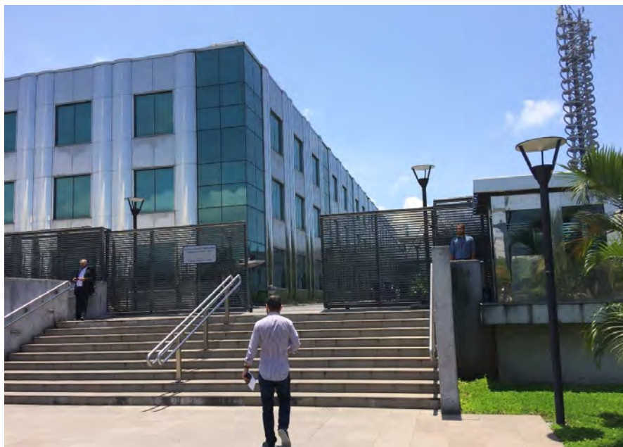
ACESSO AO EDIFÍCIO
