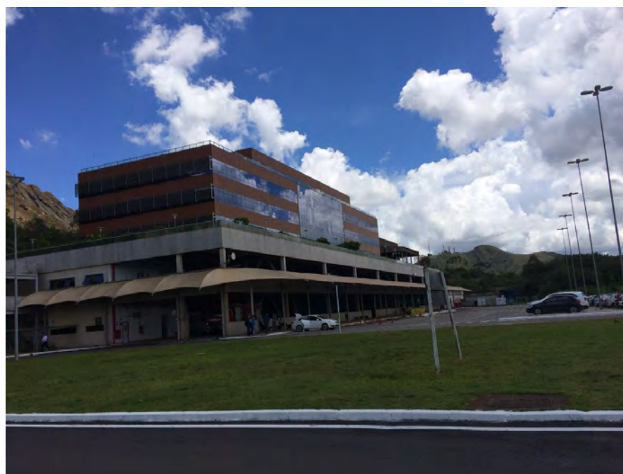
ACESSO AO EDIFÍCIO
