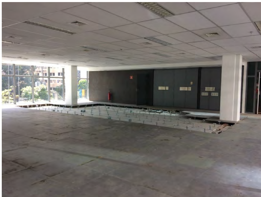
ÁREA DE ESCRITÓRIOS DO PAVIMENTO TIPO
