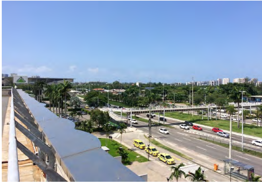
ACESSO EDIFÍCIO – AVENIDA AYRTON SENNA
