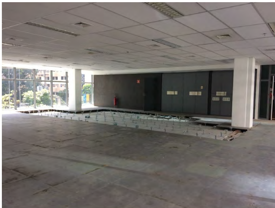
ÁREA DE ESCRITÓRIOS DO PAVIMENTO TIPO
