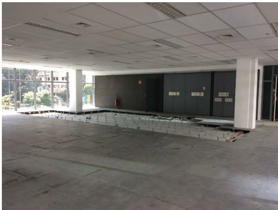
ÁREA DE ESCRITÓRIOS DO PAVIMENTO TIPO
