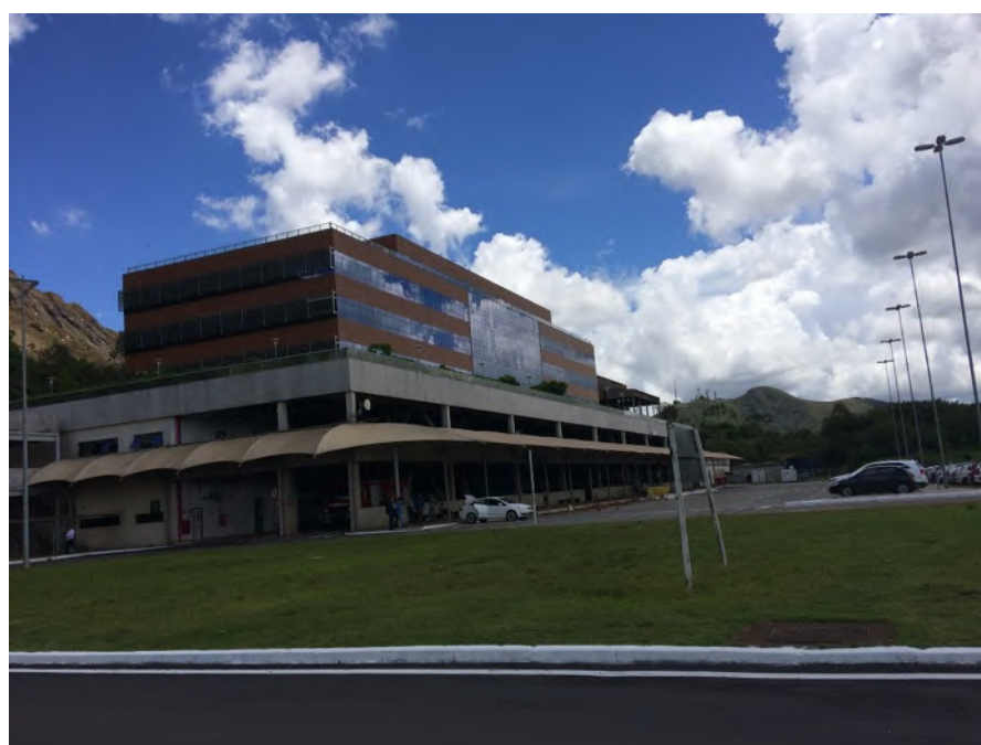
ACESSO AO EDIFÍCIO
