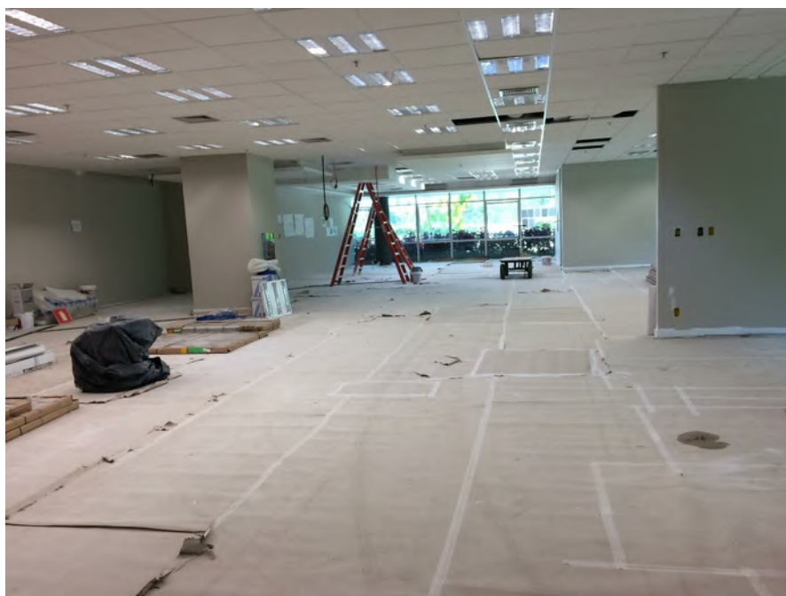
ÁREA EM REFORMA PARA OCUPAÇÃO – 1º PAVIMENTO
