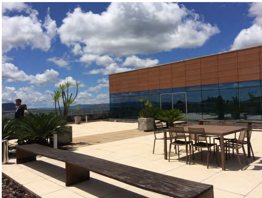
COBERTURA – ÁREA EXTERNA
