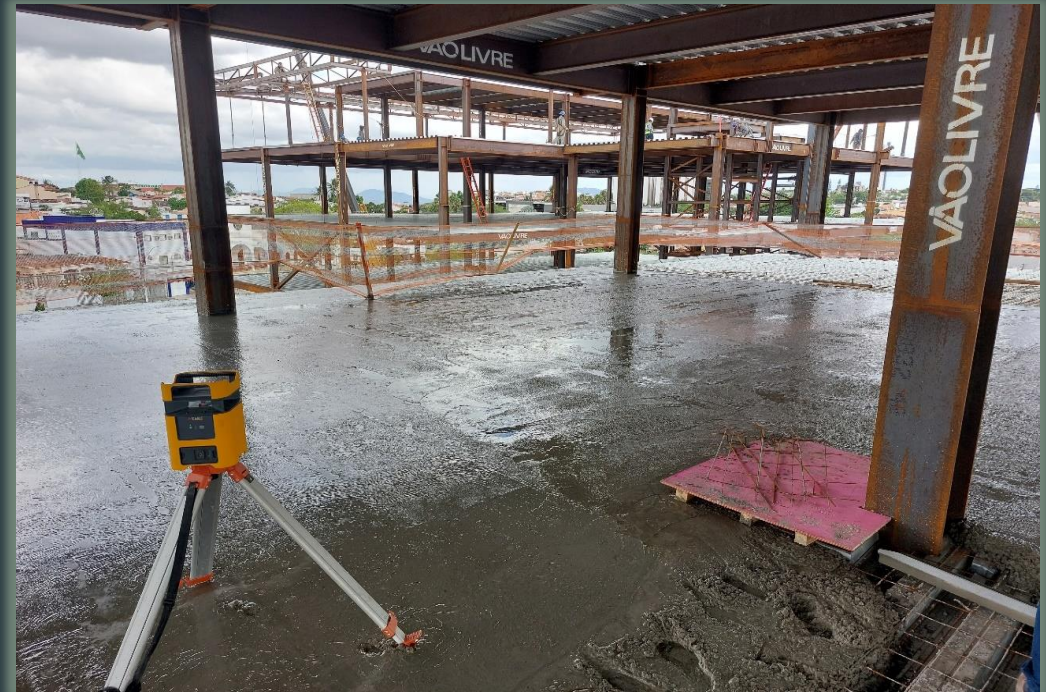
Concretagem das lajes.
