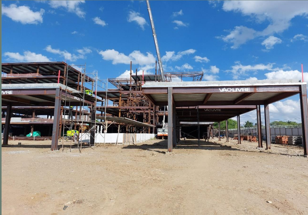
Montagem de estrutura metálica.
