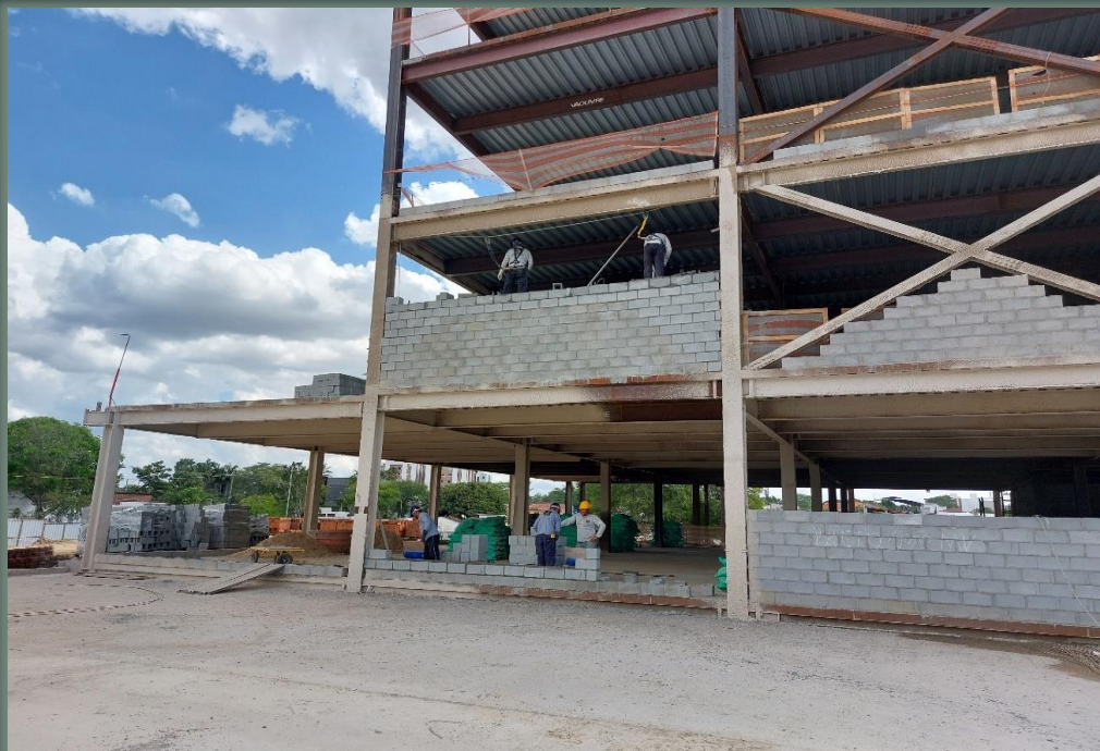
Execução das alvenarias
