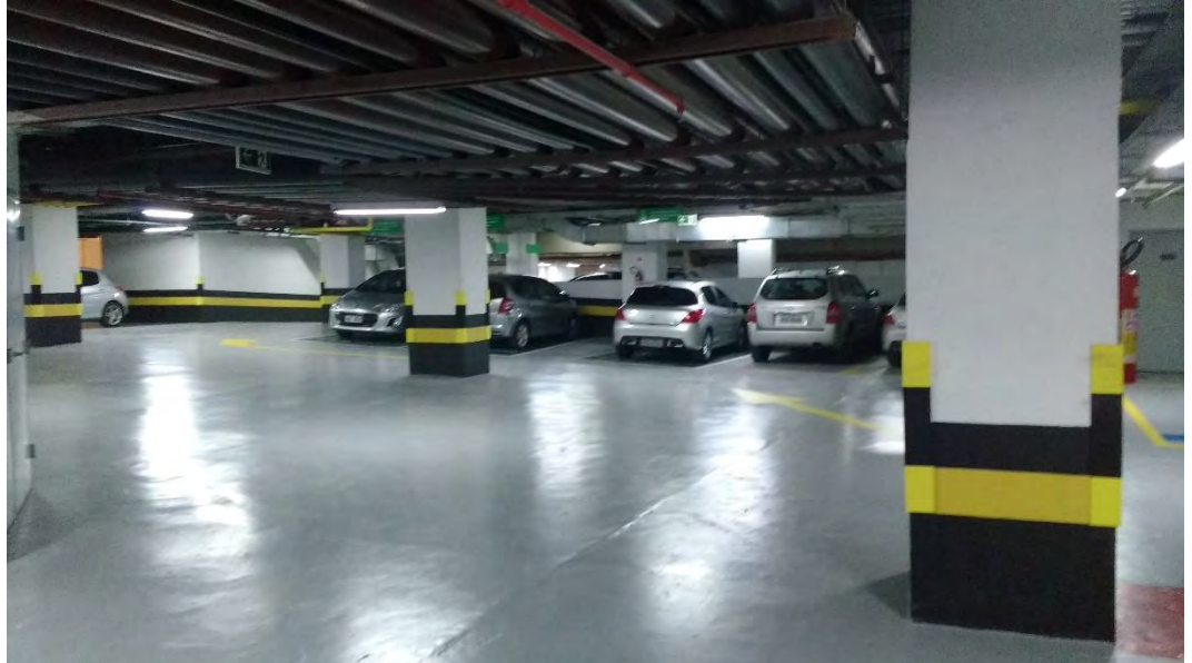
ESTACIONAMENTO NO SUBSOLO
