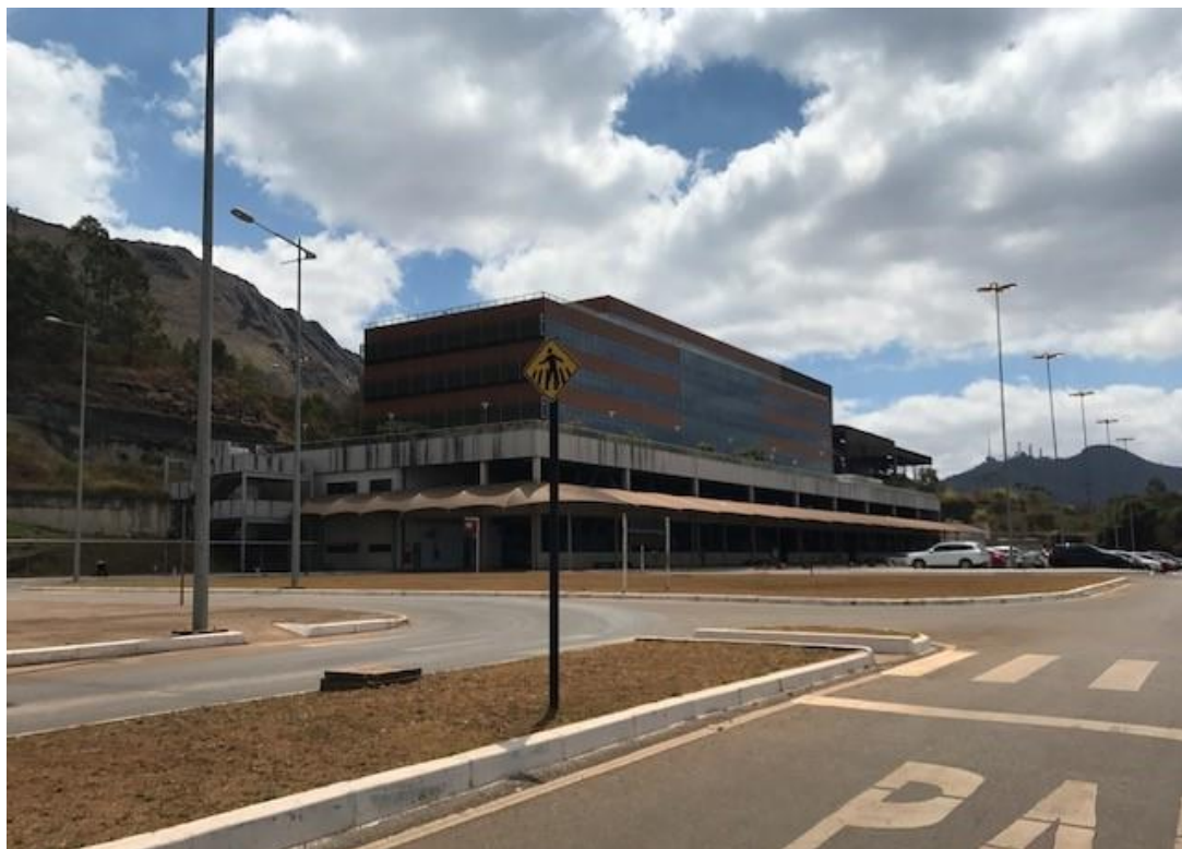
FACHADA E ACESSO AO EDIFÍCIO (PRÉDIO IV)
