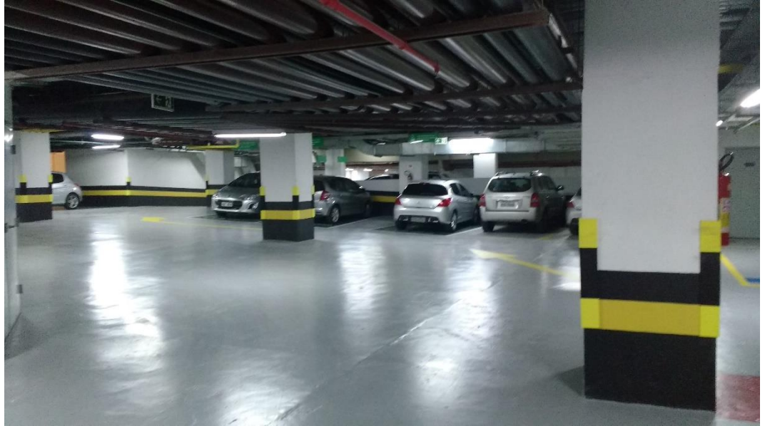
ESTACIONAMENTO NO SUBSOLO
