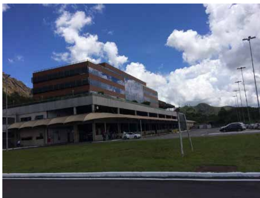
ACESSO AO EDIFÍCIO
