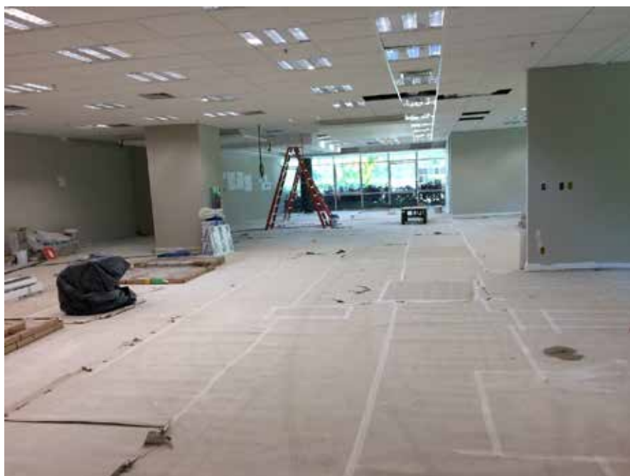
ÁREA EM REFORMA PARA OCUPAÇÃO – 1º PAVIMENTO
