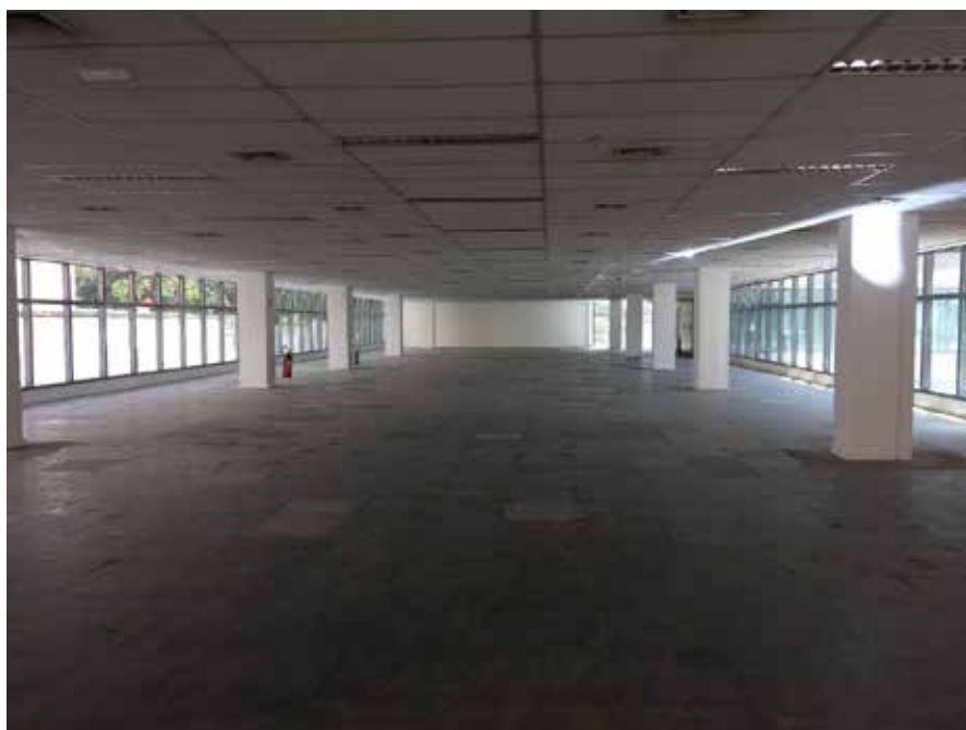
ÁREA DE ESCRITÓRIOS DO PAVIMENTO TIPO
