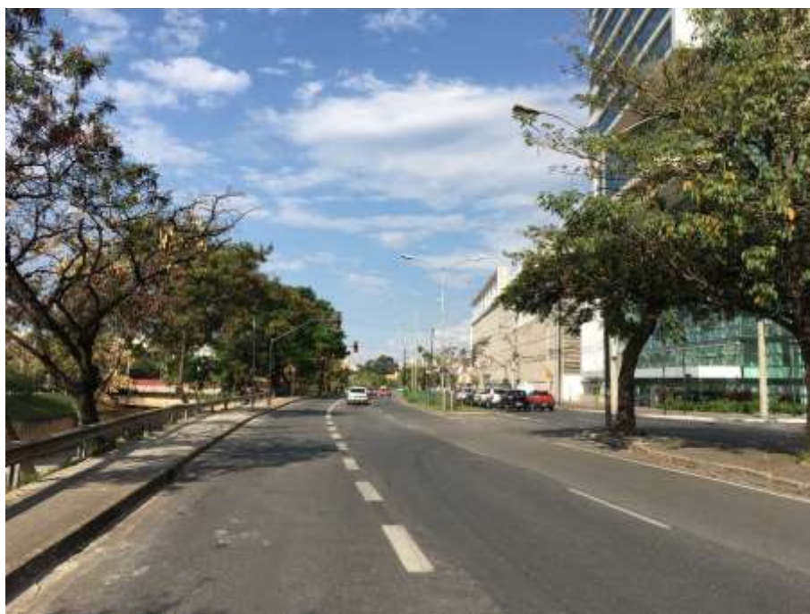
Avenida dos Andradas, com o imóvel à direita
