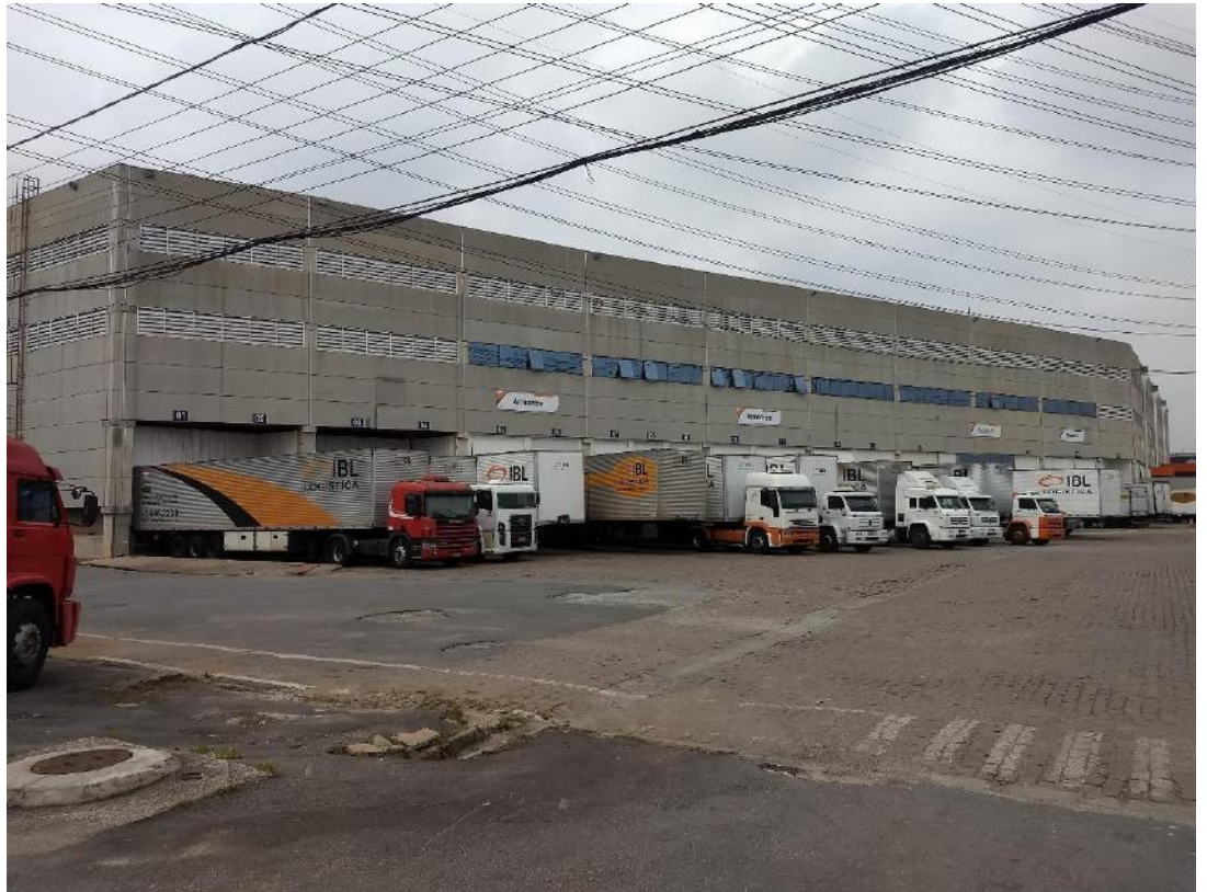
ÁREA EXTERNA DO GALPÃO
