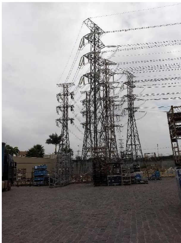
TORRES DA LINHA DE TRANSMISSÃO
