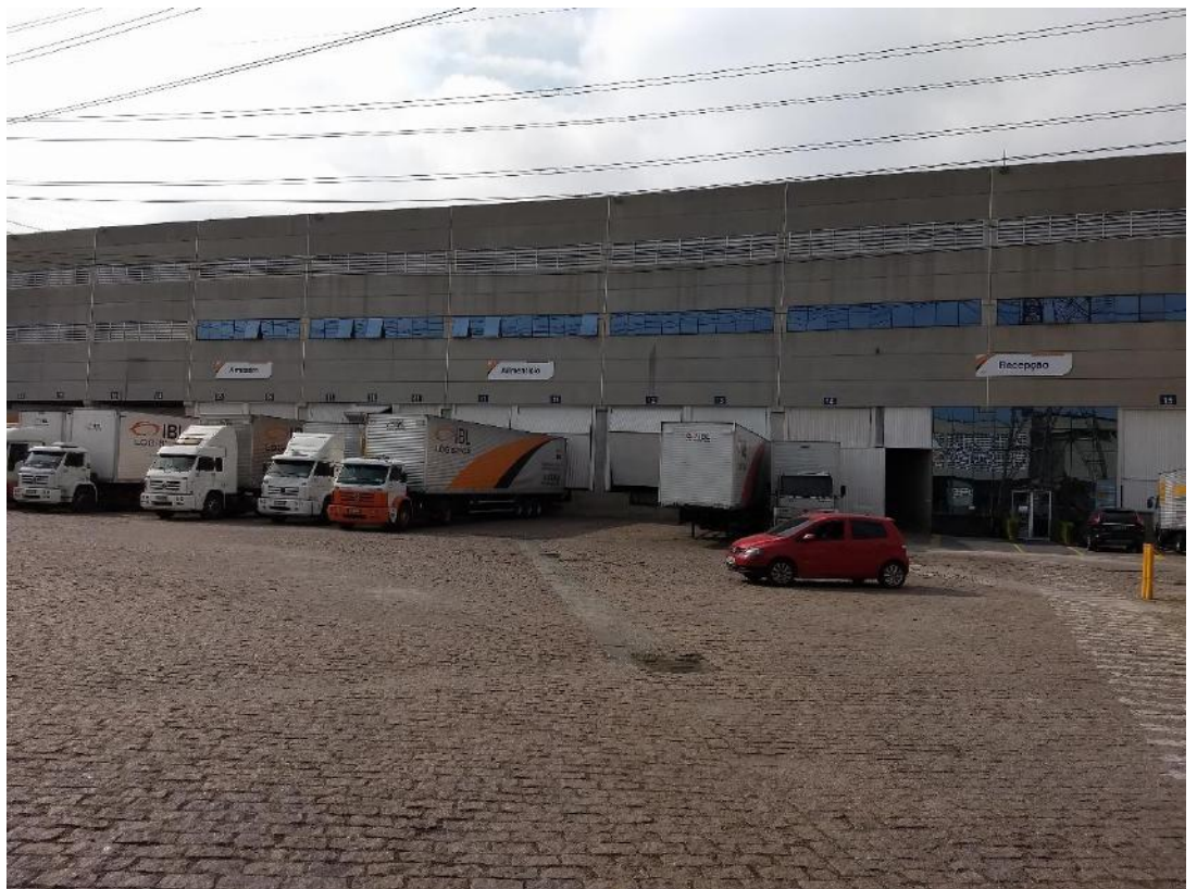
ÁREA EXTERNA DO GALPÃO
