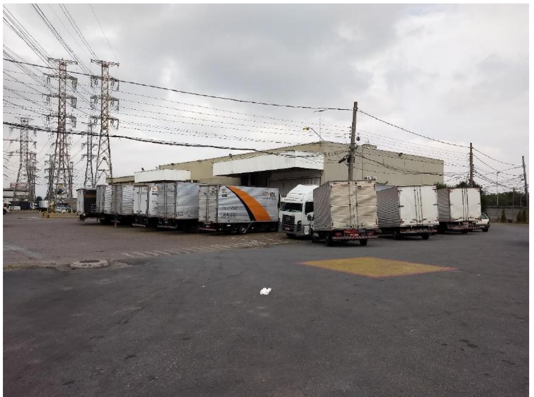
ÁREA DE MANOBRAS E PRÉDIOS DE APOIO
