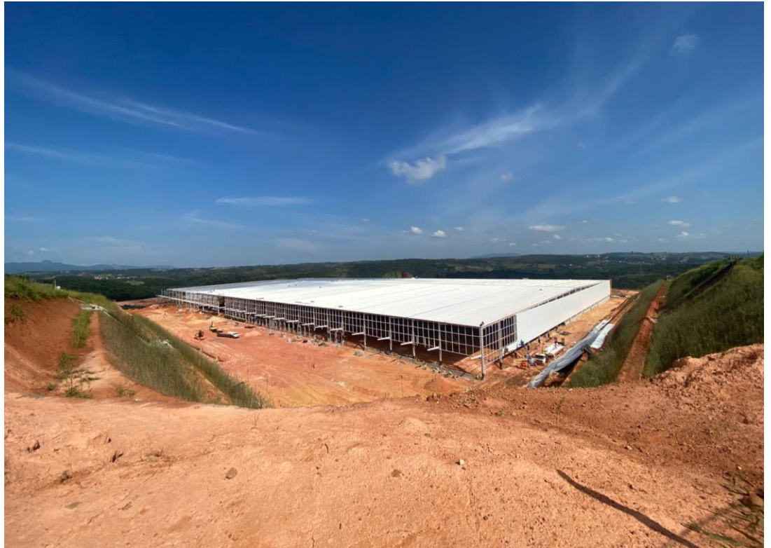
VISTA EXTERNA DO GALPÃO EM CONSTRUÇÃO
