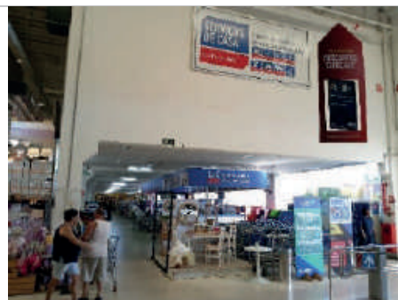
Detalhe da estrutura do mezanino
