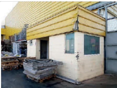
Banheiro e depósito
