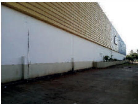
Fachada da Av. Fábio Barreto
