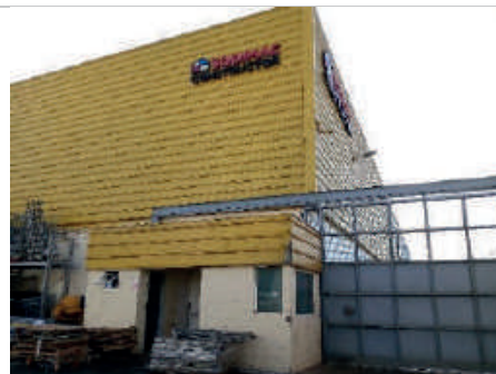
Vista parcial da fachada
