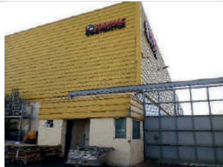
Vista parcial da fachada
