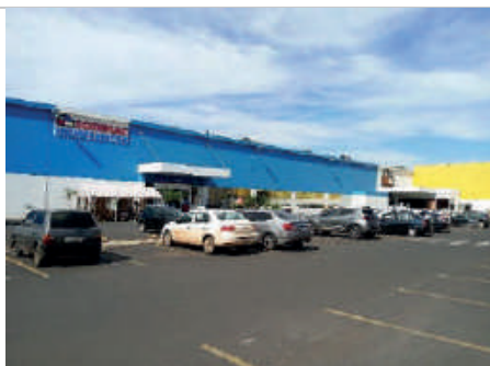
Fachada do Estacionamento
