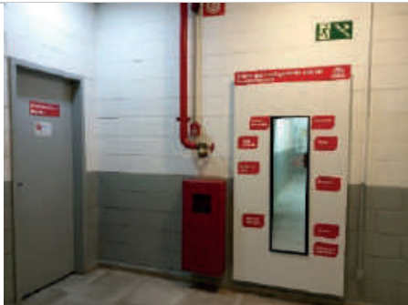
Pontos de hidrante do sistema contra incêndio mezanino
