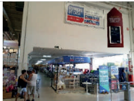
Detalhe da estrutura do mezanino
