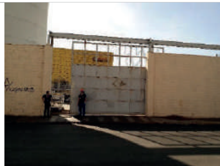
Portão de acesso pela Rua Castro Alves
