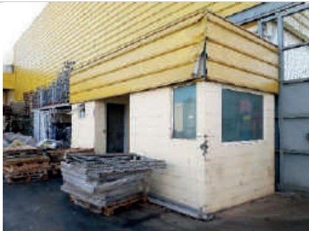
Banheiro e depósito
