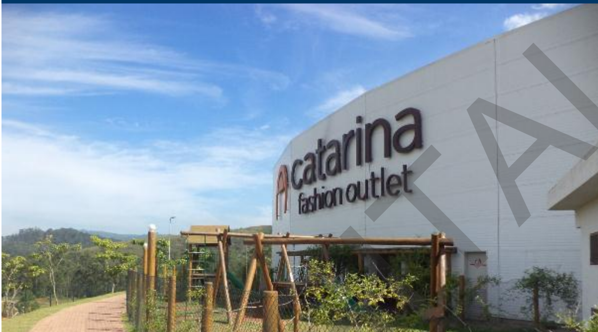
FACHADA DA PROPRIEDADE
