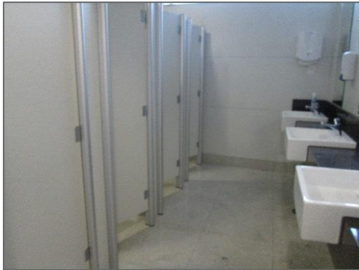
29º andar – Sanitário
