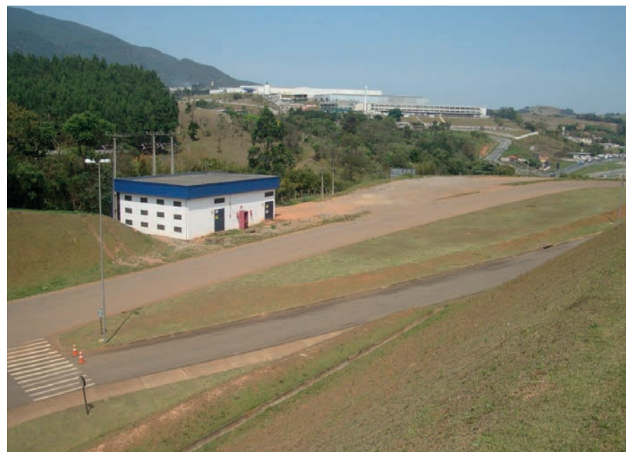
CABINE DE FORÇA
