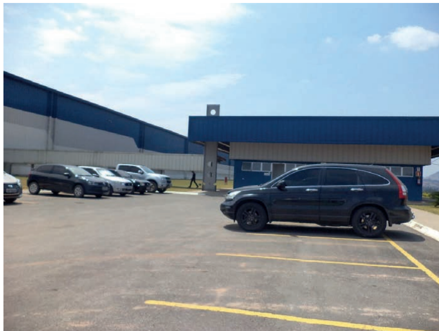
ESTACIONAMENTO E BLOCO ADMINISTRATIVO
