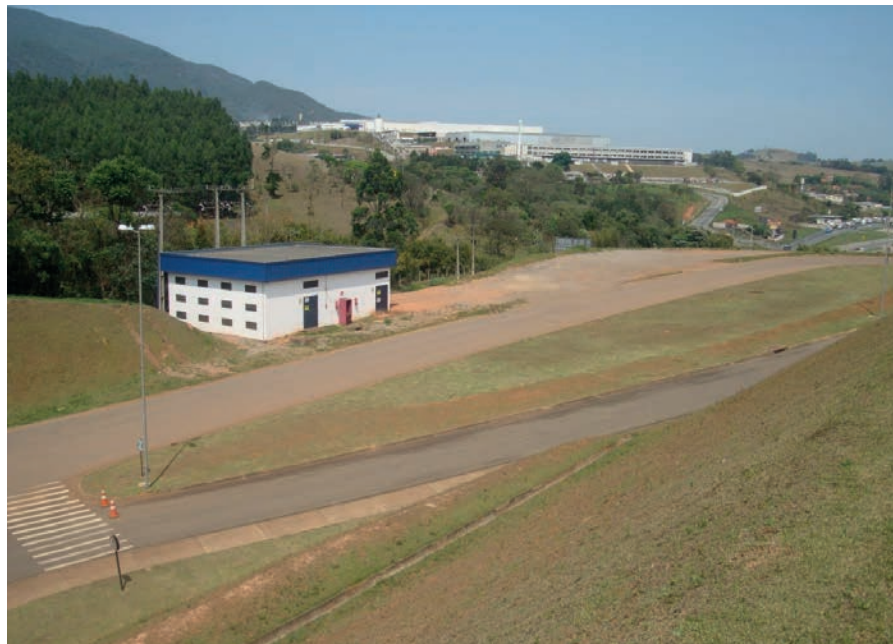
CABINE DE FORÇA
