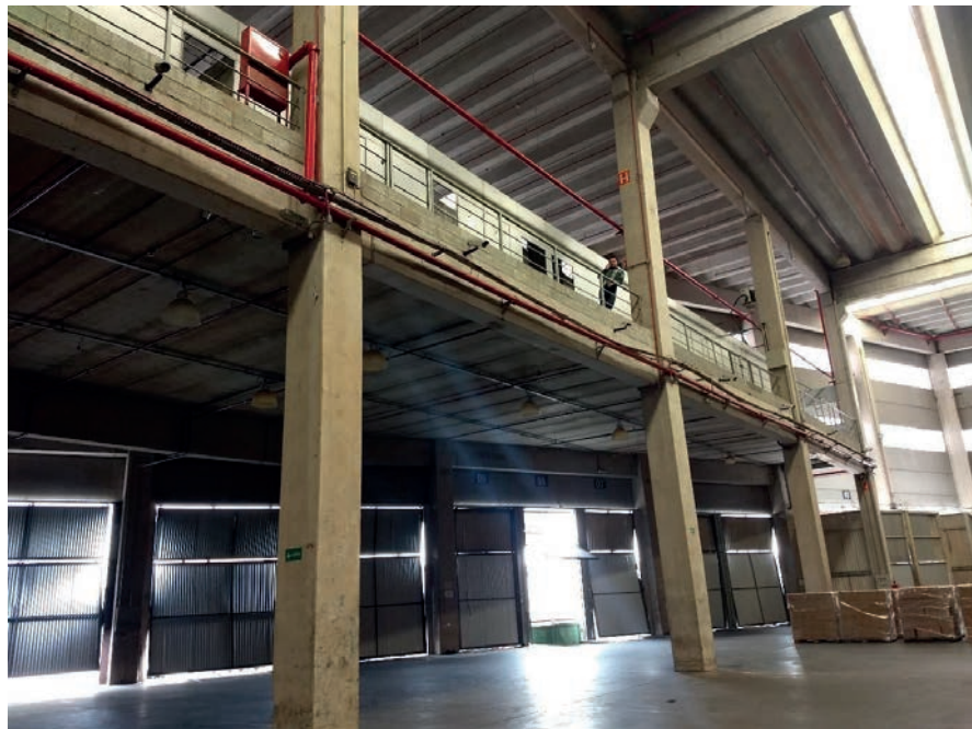
MEZANINO DO GALPÃO
