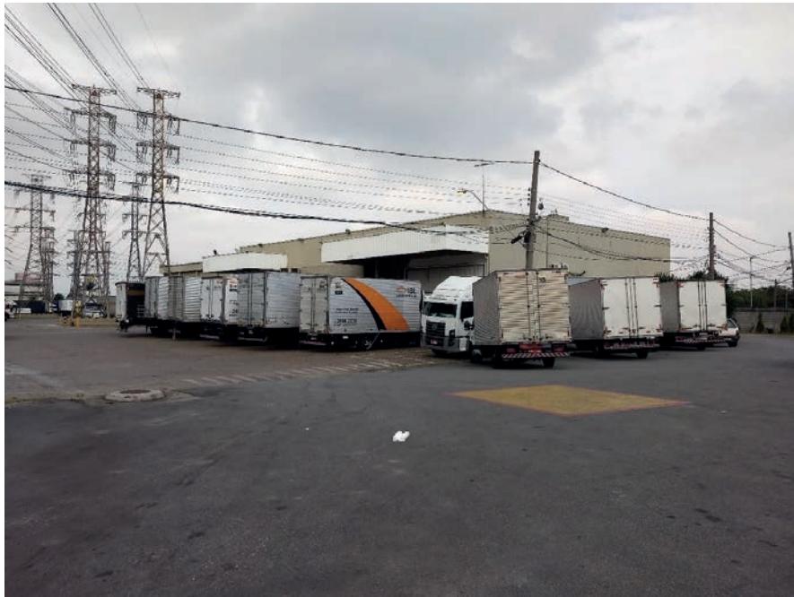
ÁREA DE MANOBRAS E PRÉDIOS DE APOIO
