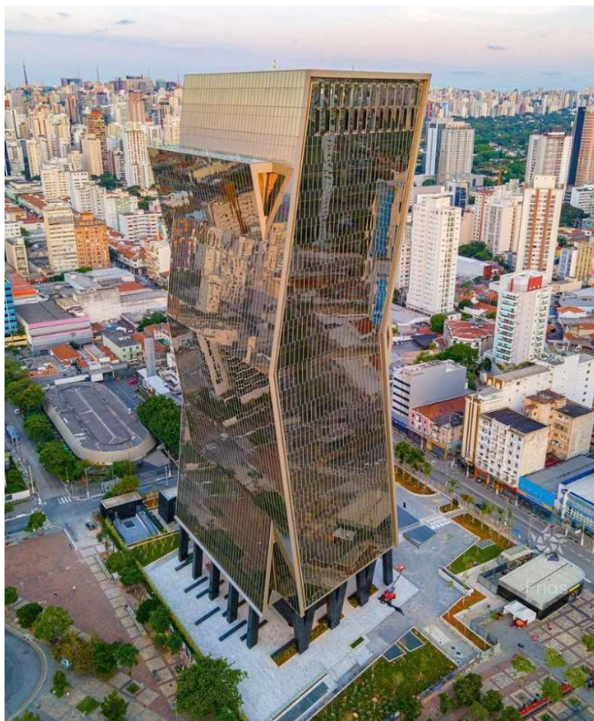
Fotos do Edifício FL Plaza
