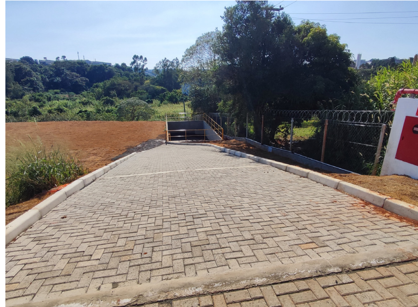
Acesso ao Terreno de Ampliação
