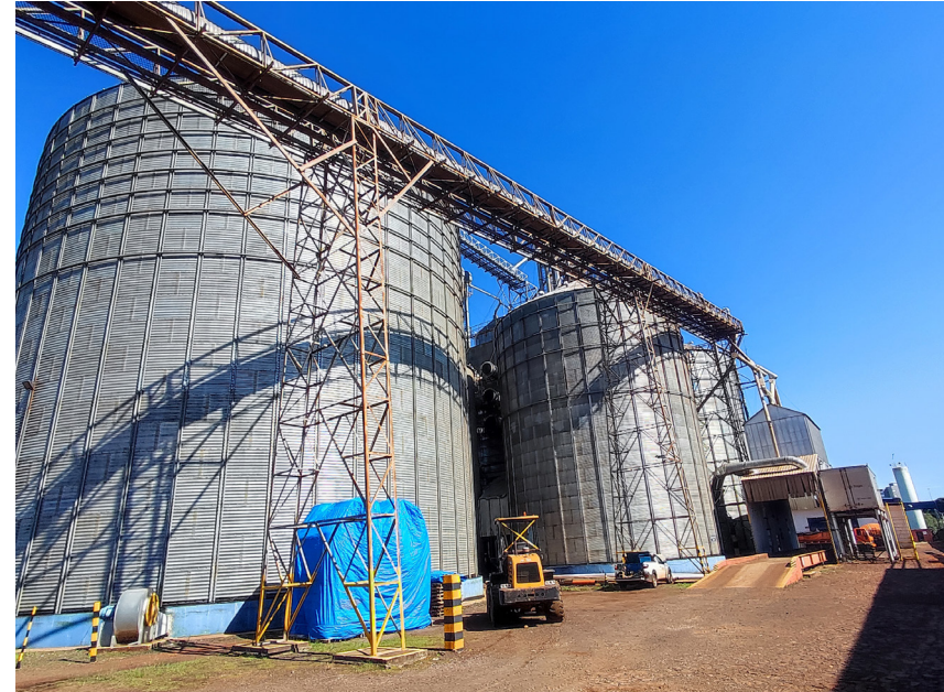
Silos Armazenamento de Grãos
