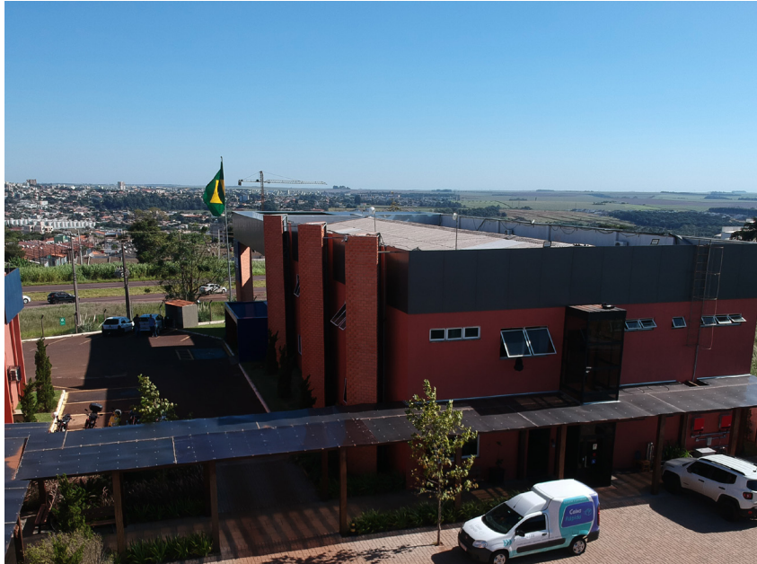
Fachada Prédio Operações
