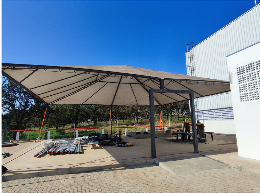
Área para Instalação da Estação de Tratamento de Esgoto
