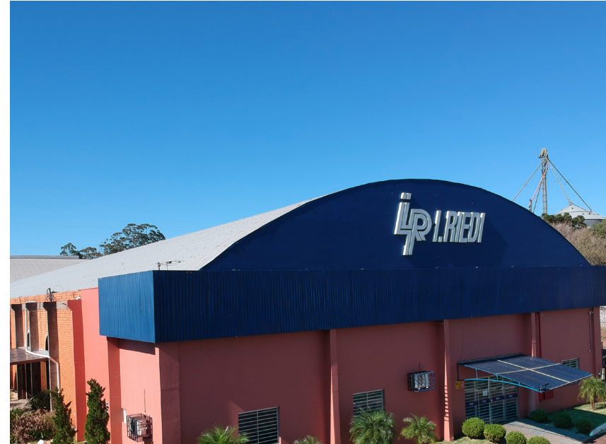
Fachada Prédio Operações
