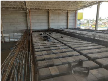
Montagem das cubetas
