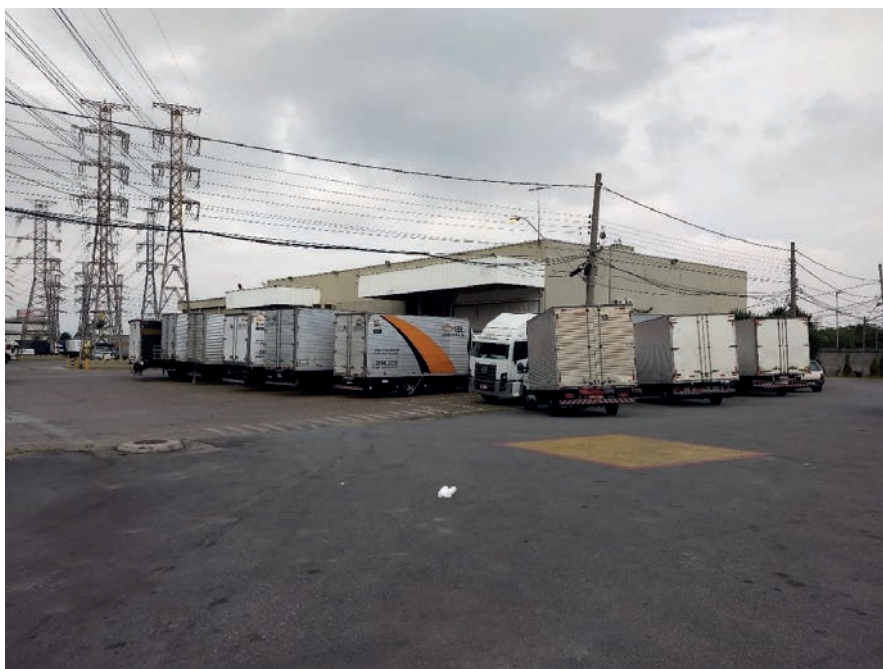
ÁREA DE MANOBRAS E PRÉDIOS DE APOIO
