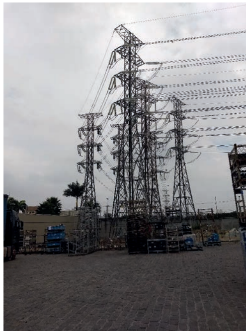
TORRES DA LINHA DE TRANSMISSÃO
