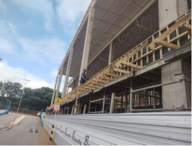
Travamento das vigas
