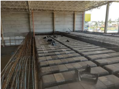
Montagem das cubetas
