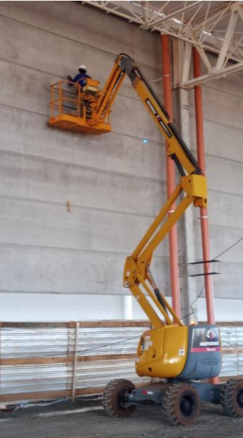
Tratamento das juntas
