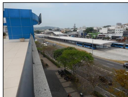
Avenida Armando Lombardi sentido Avenida Ministro Ivan Lins
