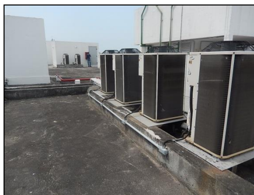
Área técnica (cobertura)
