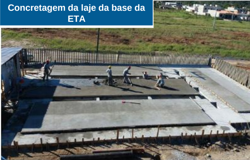
Regularização da laje da base da ETA
