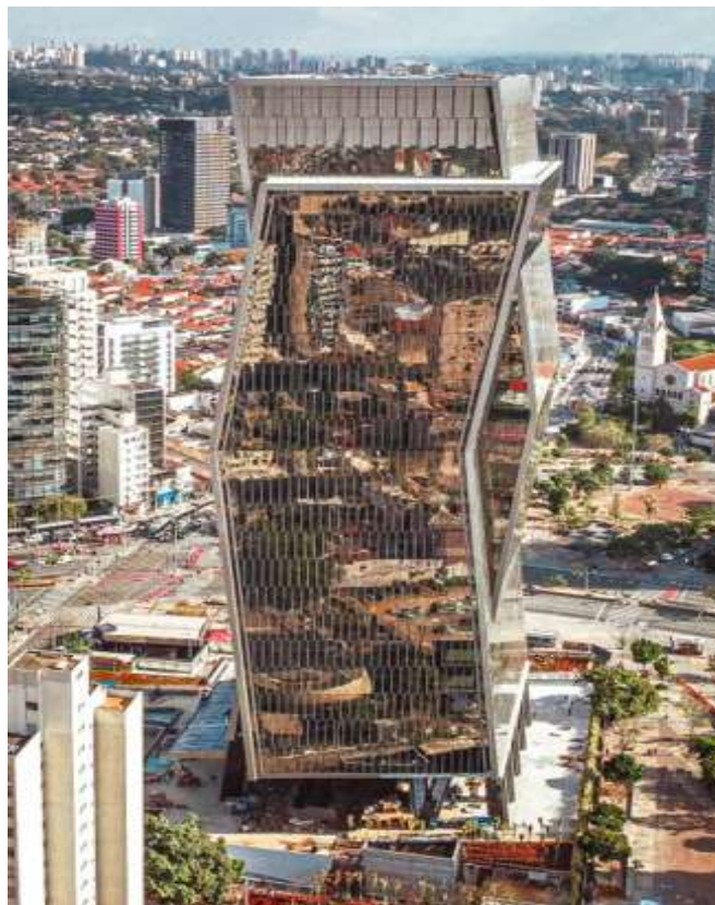
Foto da obra em andamento
