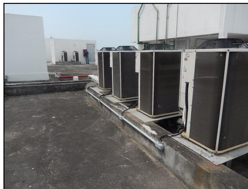
Área técnica (cobertura)
