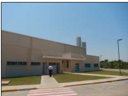
Escritórios, vestiários e sala de baterias
