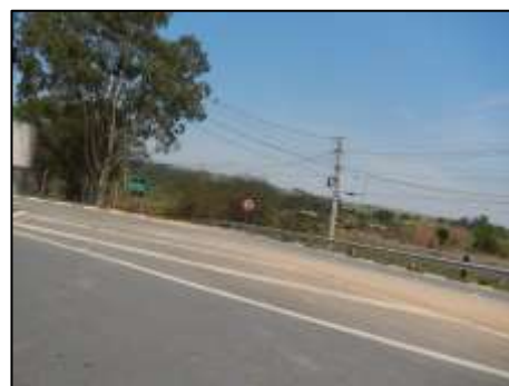
Rua Tobias Bueno de Oliveira sentido Estrada Municipal Rio Acima
