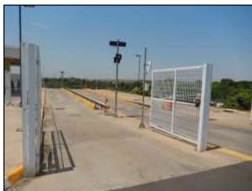
Acesso de veículos e balança rodoviária
