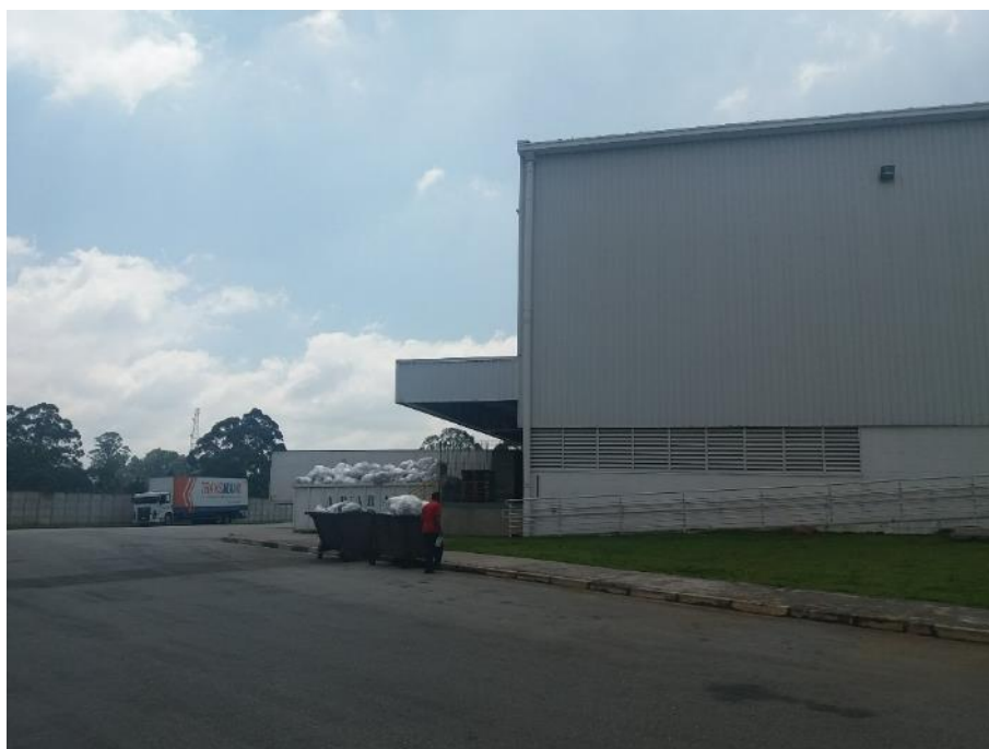
Área externa do galpão
