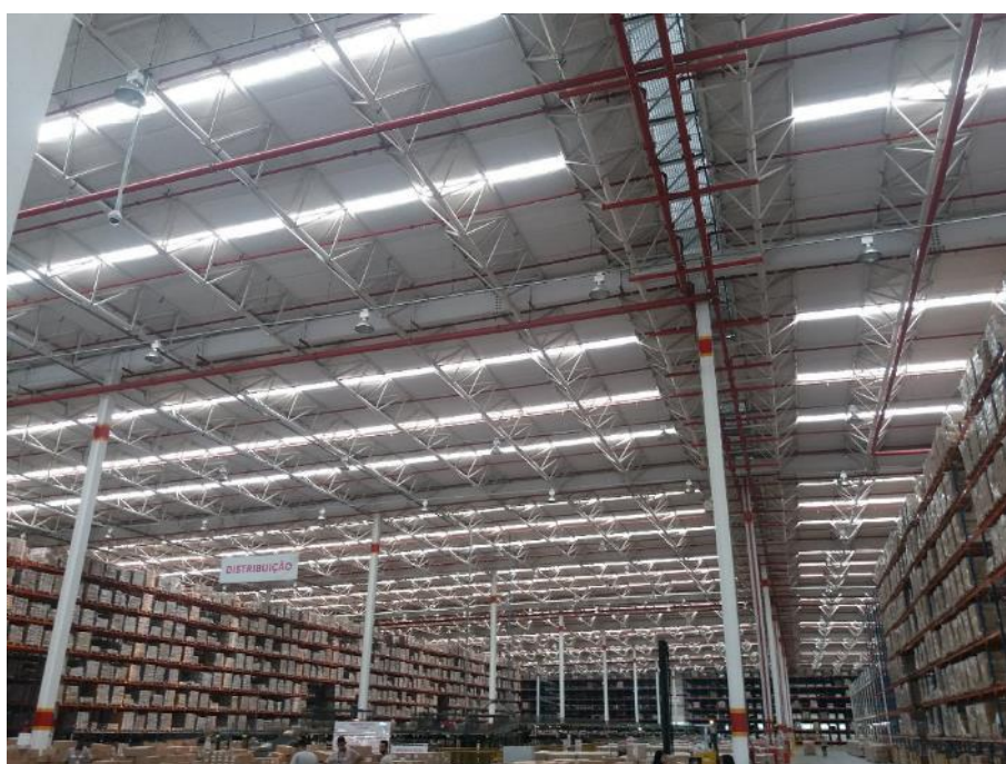
Área interna do galpão
